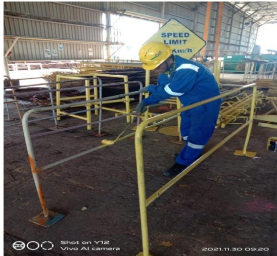
Gambar 2. 35 Painting pada Cable Hanger
