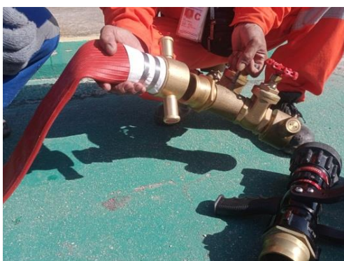
Gambar 2. 21 proses penyambungan fire hose ke manifold
