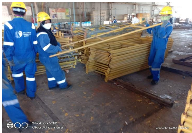
Gambar 2. 29 proses pengangkatan cable hanger ke rak
