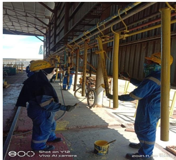
Gambar 2. 34 Proses painting pada cable hanger
