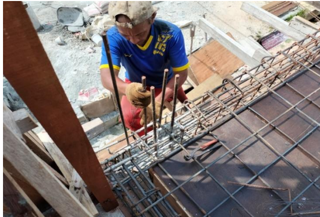
Gambar 3. 97 Proses pemasangan stek kolom (Sumber: Dokumentasi Kuliah Praktek, 2022)
