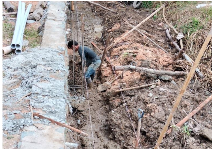
Gambar 3. 26 Penggalian tanah pembersihan lahan (Sumber: Dokumentasi Kuliah Praktek, 2022)
