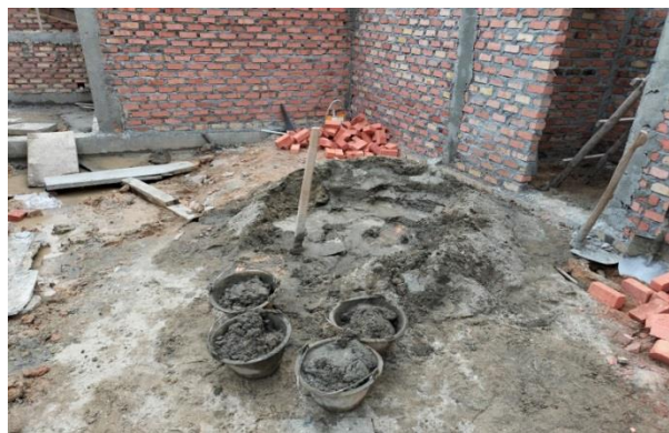
Gambar 3. 87 Adukan Beton (Sumber: Dokumentasi Kuliah Praktek, 2022)
