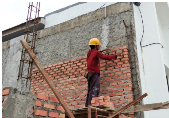
Gambar 3. 88 Pasang dinding bata (Sumber: Dokumentasi Kuliah Praktek, 2022)
