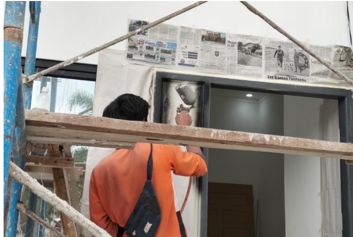
Gambar 3. 78 Cat semua permukaan hingga rata (Sumber: Dokumentasi Kuliah Praktek, 2022)
