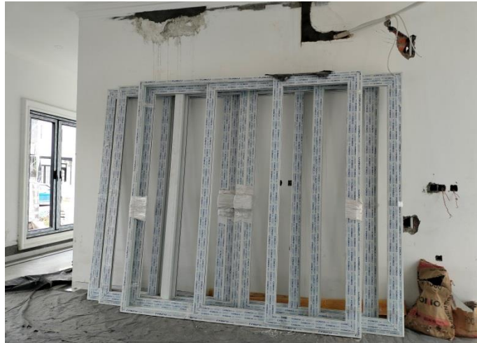
Gambar 3. 68 Daun Pintu aluminium Sliding (Sumber: Dokumentasi Kuliah Praktek, 2022)
