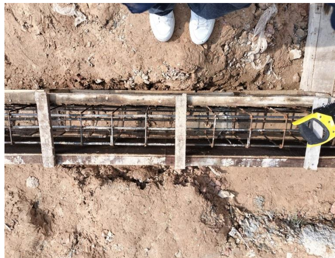
Gambar 3. 59 Bekisting Sloof (Sumber: Dokumentasi Kuliah Praktek, 2022)
