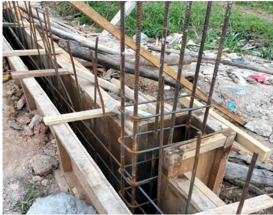
Gambar 3. 25 Bekisting (Sumber: Dokumentasi Kuliah Praktek, 2022)
