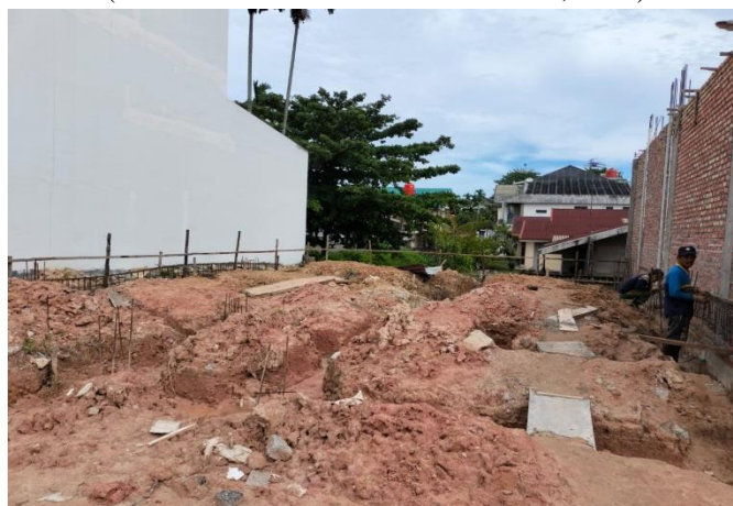
Gambar 3. 8 Pekerjaan pile cap (Sumber: Dokumentasi Kuliah Praktek, 2022)
