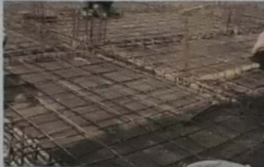
3. Rakitan tulangan plat lantai
