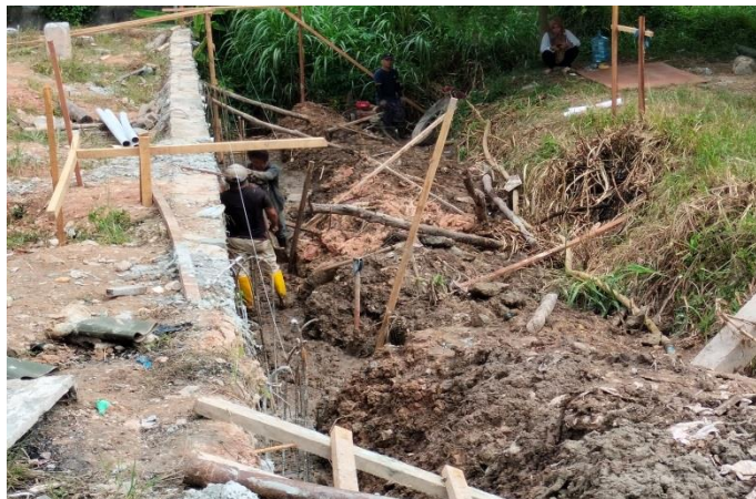
Gambar 3. 24 Proses pemasangan Bowplank
