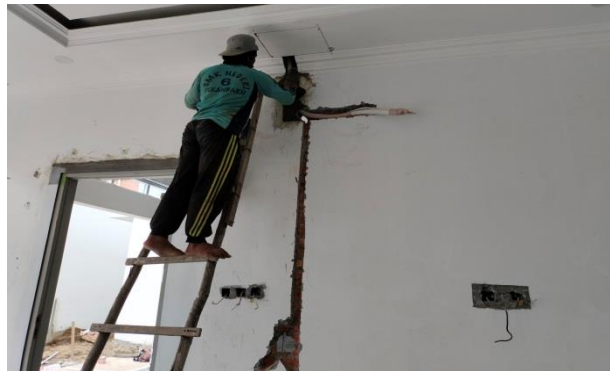
Gambar 3. 51 Penutupan lobang bekas AC (Sumber: Dokumentasi Kuliah Praktek, 2022)
