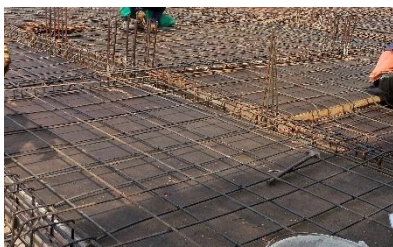
Gambar 3. 93 Rakitan Tulangan Plat Lantai
