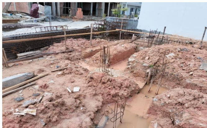
Gambar 3. 7 Galian Tanah untuk pile cap (Sumber: Dokumentasi Kuliah Praktek, 2022)
