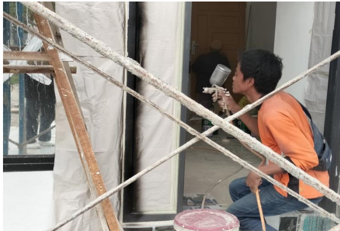
Gambar 3. 76 pengecekan alat cat kompresor (Sumber: Dokumentasi Kuliah Praktek, 2022)
