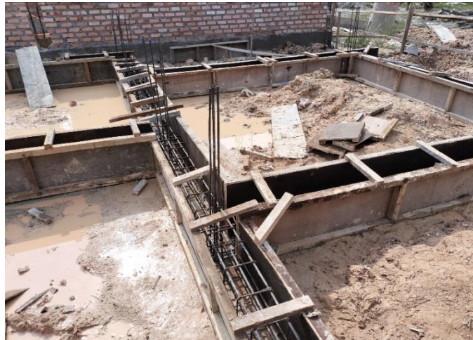
Gambar 3. 58 Pemasangan Bekisting Sloof (Sumber: Dokumentasi Kuliah Praktek, 2022)
