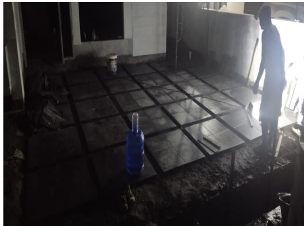
Gambar 3. 35 Pemasangan keramik Carport (Sumber: Dokumentasi Kuliah Praktek, 2022)
