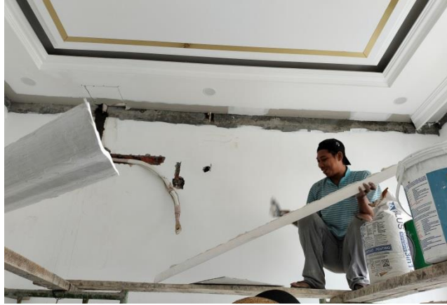
Gambar 3. 43 Pengaplikasian Lem cornice pada list Gypsum (Sumber: Dokumentasi Kuliah Praktek, 2022)
