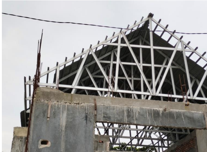
Gambar 3. 107 Pasang rangka baja atap (Sumber: Dokumentasi Kuliah Praktek, 2022)
