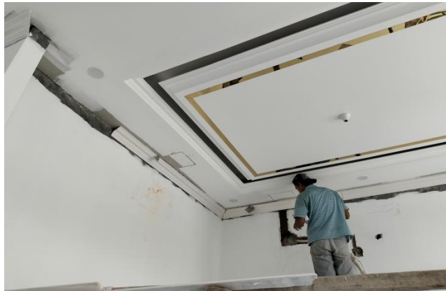
Gambar 3. 44 Pasang list Gypsum pada plafon (Sumber: Dokumentasi Kuliah Praktek, 2022)
