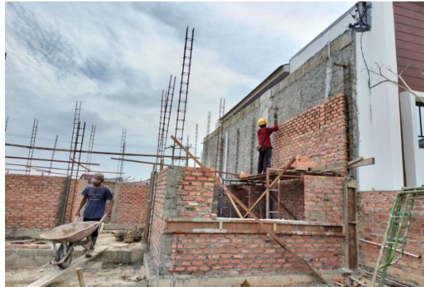
Gambar 3. 89 Tampak jauh pemasangan dinding bata (Sumber: Dokumentasi Kuliah Praktek, 2022)
