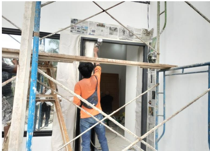
Gambar 3. 77 Cat kusen dengan kompresor (Sumber: Dokumentasi Kuliah Praktek, 2022)
