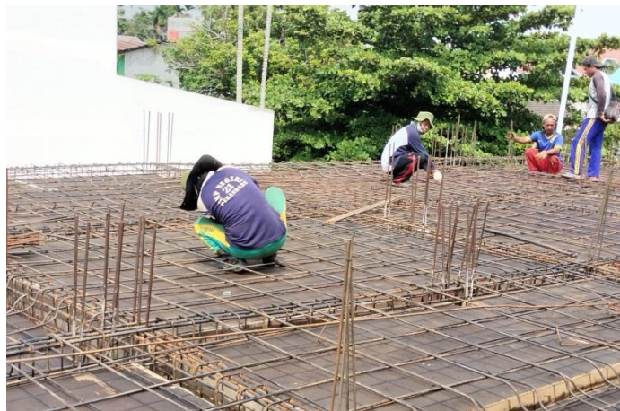
Gambar 3. 96 Pasang bekisting dan tulangan plat (Sumber: Dokumentasi Kuliah Praktek, 2022)
