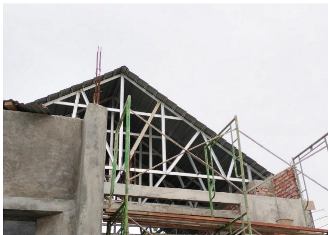
Gambar 3. 108 Pemasangan atap baja ringan (Sumber: Dokumentasi Kuliah Praktek, 2022)
