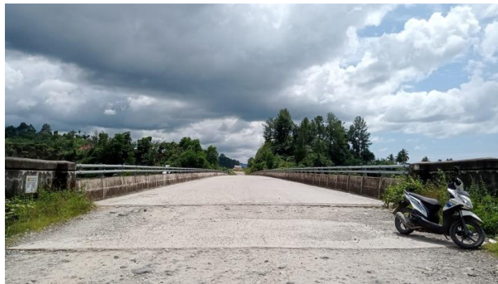
Gambar 1. 1 Kondisi eksisting jembatan (Sumber: Dokumentasi Lapangan Skripsi)
