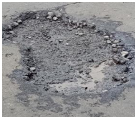
Gambar 2. 18 Pelapukan dan Butiran Lepas (Sumber: Bina Marga, 1990)
