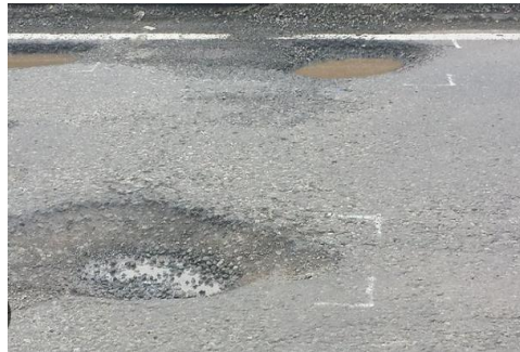
Gambar 2. 17 Lubang (Sumber: Bina Marga, 1990)
