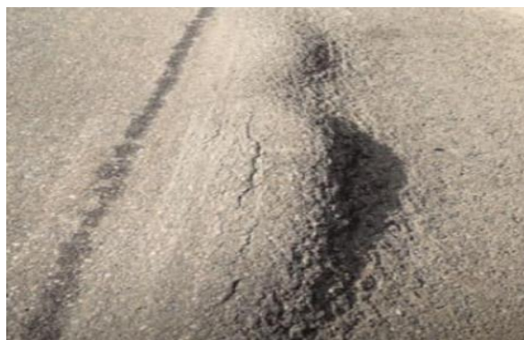
Gambar 2. 15 Sungkur (Sumber: Bina Marga, 1990)
