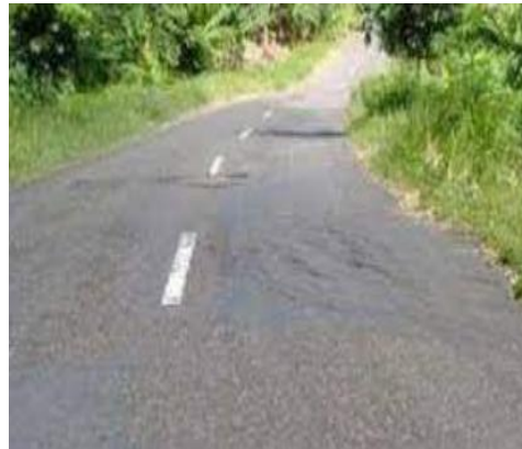
Gambar 2. 14 Mengembang (Swell) (Sumber: Bina Marga, 1990)
