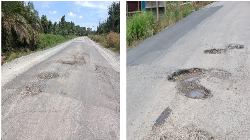
Gambar 1. 1 Jalan Sultan Syarif Kasim Sepanjang 3.1 km Desa teluk masjid Kecamatan Sungai Apit Kabupaten Siak (Sumber: Dokumentasi Lapangan)
