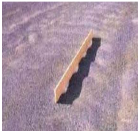
Gambar 2. 12 Bergelombang (keriting) (Sumber: Bina Marga, 1990)
