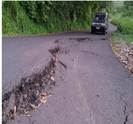
Gambar 2. 13 Amblas (Sumber: Bina Marga, 1990)
