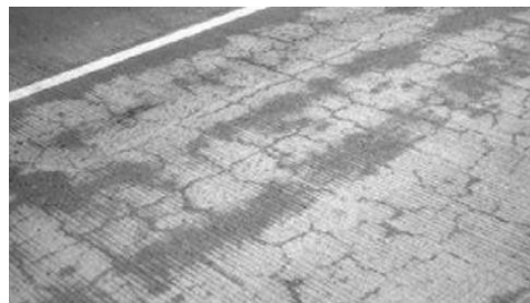
Gambar 2. 10 Retak Susut (Sumber: Bina Marga, 1990)
