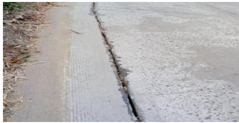
Gambar 2. 8 Retak Sambungan Pelebaran Jalan (Sumber: Bina Marga, 1990)
