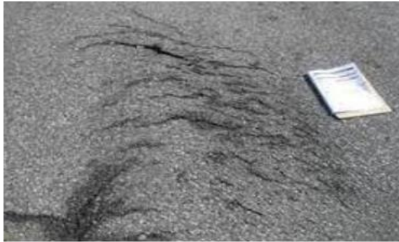
Gambar 2. 16 Tonjolan Dan Turun (Hump and Sags) (Sumber: Bina Marga, 1990)
