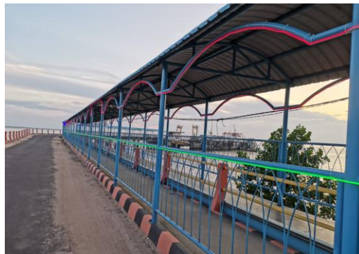
Gambar 2.6 Jetty, Trestle, dan Catwalk Dermaga
