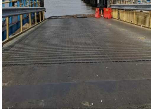
Gambar 2.3 Pelampung atau Ponton Dermaga
