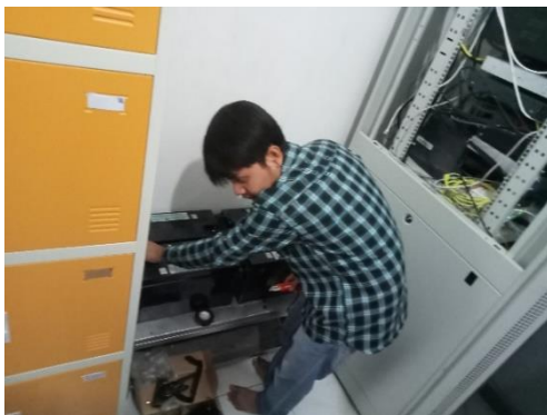
Gambar 3.13. Pemasangan Baterai Baru
