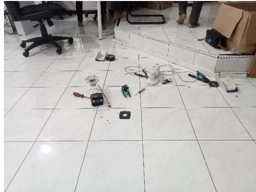
Gambar 3.18. Beberapa CCTV yang Sudah Dibongkar
