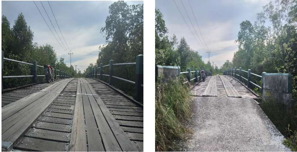
Gambar 1.1 Jembatan Aki Baki Tanjung Pisang (Sumber: Dokumentasi Lapangan)
