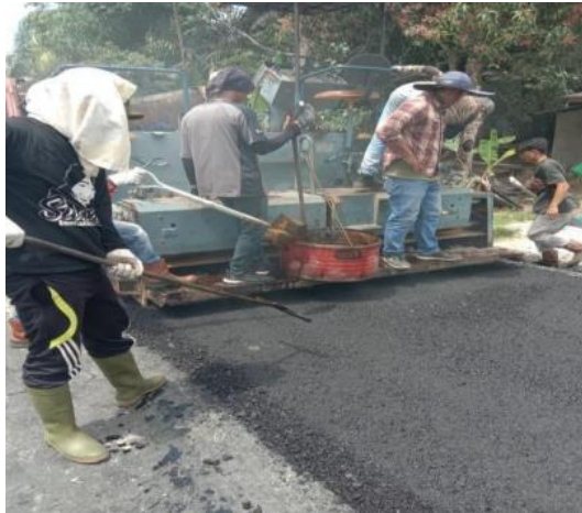
Gambar 3.10. pengecakan kemiringan transversal
