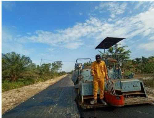
Gambar 3.9. pengecekan tebal lapisan aspal
