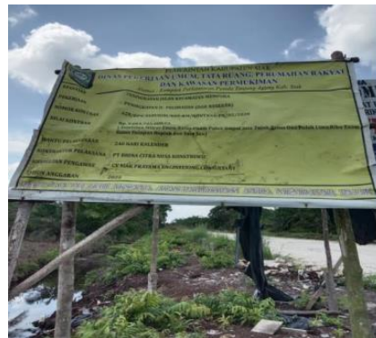
Gambar 2.1. Papan Nama Proyek Peningkatan Jalan Pelimauan
