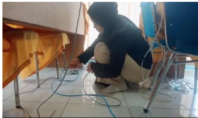
Gambar 3. 9 Membuat Kabel Jaringan dan Melakukan Tester Kabel
