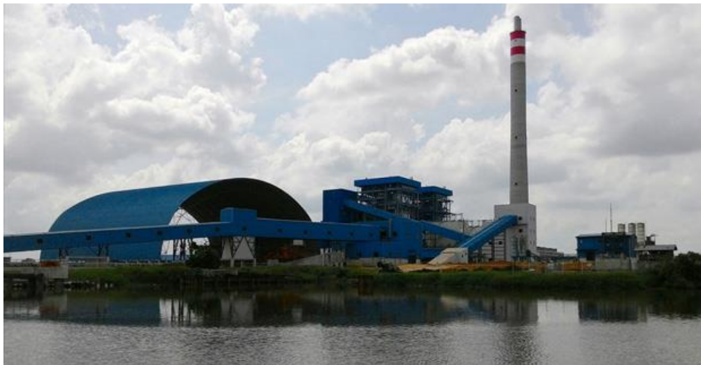
Gambar 1.3. PLTU Tenayan Dari Belakang (Sumber: Dokumentasi di PLTU TENAYAN)
