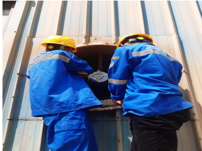
Gambar 2.37. Pemasangan Motor Exhaust fan 380V Diarea Luar CWP House
