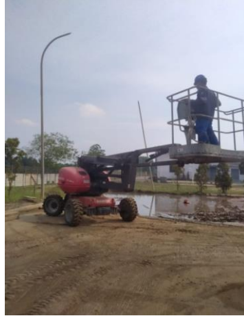
Gambar 2.47. Pemasangan Lampu Jalan 250W Diarea Ply ash (Sumber: Dokumentasi di PLTU TENAYAN)
