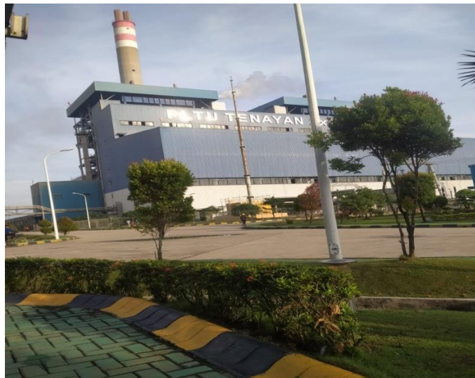
Gambar 1. 1. Penampakan PLTU Tenayan (Sumber: Dokumentasi di PLTU TENAYAN)
