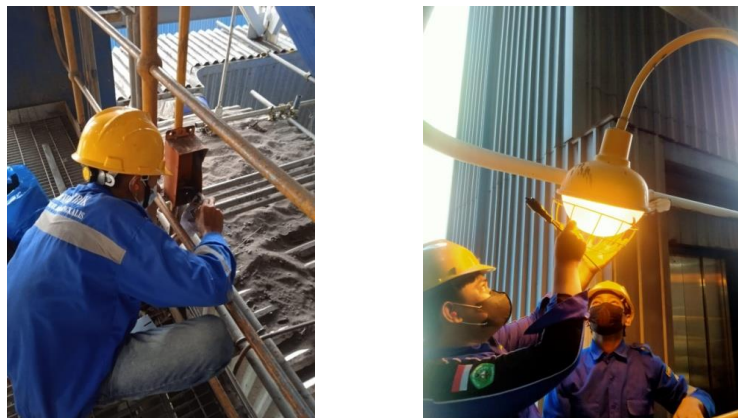
Gambar 2.48. Pemasangan Ballast Lampu Diarea Boiler (Sumber: Dokumentasi di PLTU TENAYAN)
