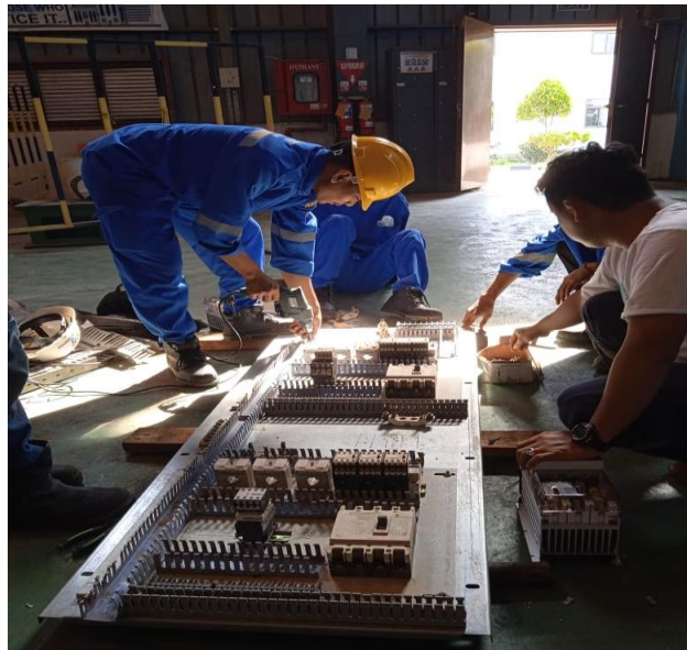
Gambar 2.38. Proses Perakitan Komponen Komponen Didalam Panel Heater
