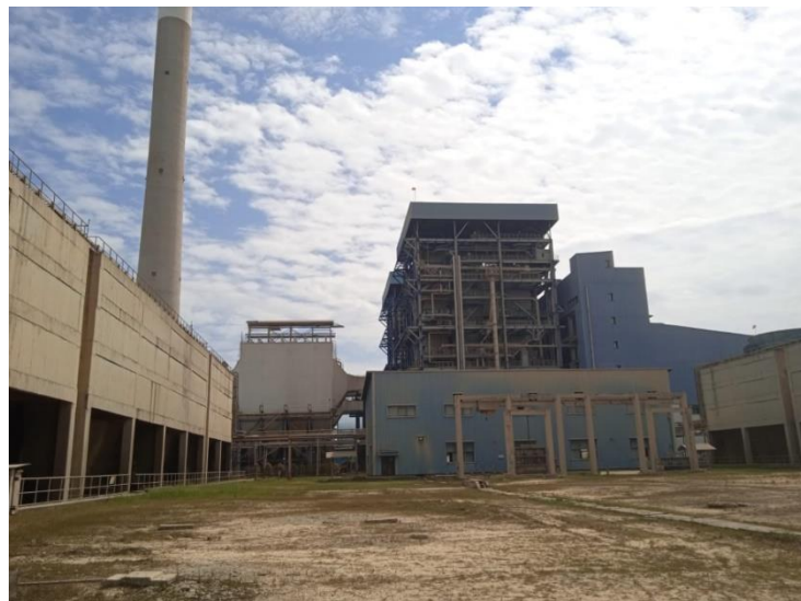
Gambar 1.2. Penampakan Salah satu Bagian PLTU Tenayan (Sumber: Dokumentasi di PLTU TENAYAN)
