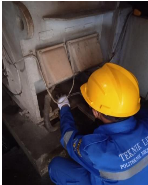
Gambar 3.14. Pemeriksaan Baut Pondasi
