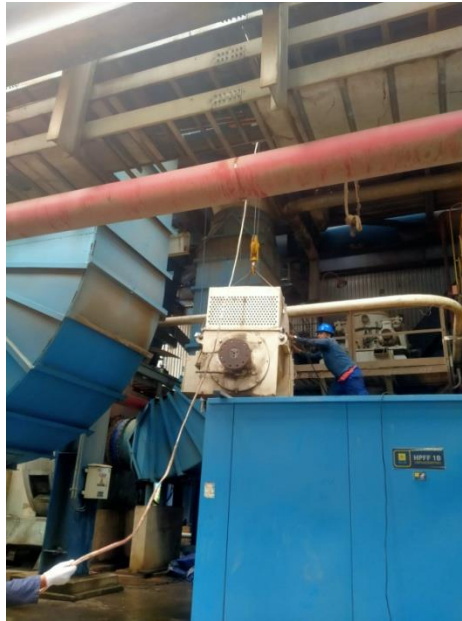
Gambar 2.42. Pemindahan Kedudukan Motor HPFF 6 Kv (Sumber: Dokumentasi di PLTU TENAYAN)
