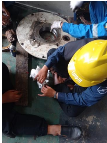
Gambar 2.46. Cleaning Pada Bearing Motor HPFF 6 Kv
