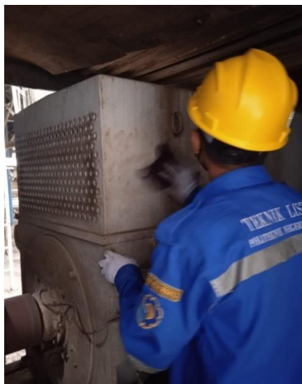
Gambar 3.16. Pembersihan Frame Motor (Sumber:Dokumentasi di PLTU TENAYAN)
