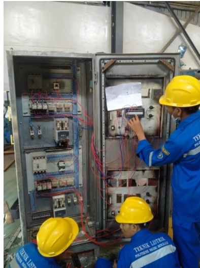
Gambar 2.39. Proses Perangkaian Pada Panel Heater
