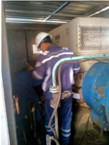
Gambar 3.17. Pemeriksaan Seal Box Terminasi
