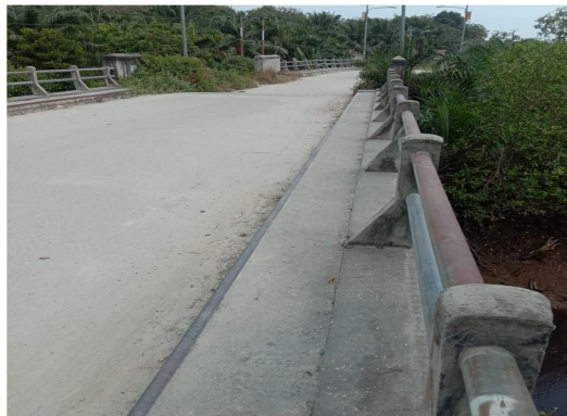
Gambar 1.1 Jembatan Sungai Mesim Desa Sukarjo Mesim (Sumber : Dokumentasi Lapangan)
