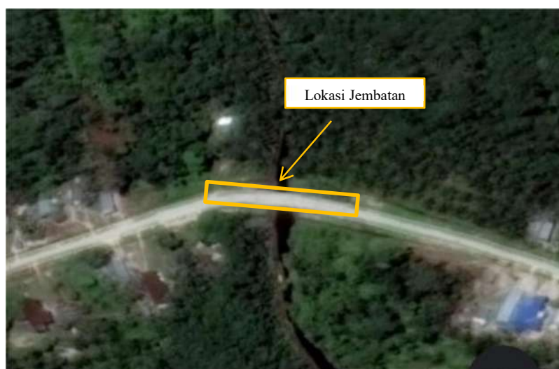
Gambar 3.2 Lokasi Jembatan di Sungai Mesim Desa Sukarjo Mesim (Sumber : Google Maps)
