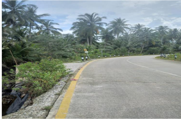
Gambar 1. 1 Kondisi Jalan yang mengalami dampak banjir
