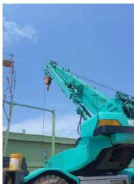
Gambar 3.1 pemasangan kolom (sumber : Dokumentasi pribadi,2022)
