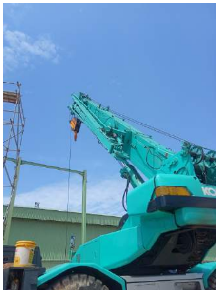
Gambar 3.2 pemasangan beam (sumber : Dokumentasi pribadi,2022)
