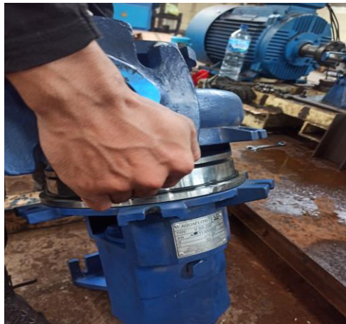
Gambar 4. 22 Pemasangan Casing Pompa
