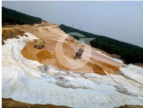
Gambar 1. 1 Perkuatan Geotextile
