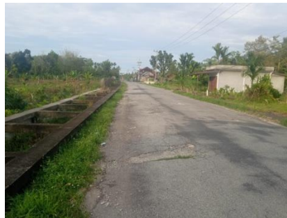
Gambar 1.1 Dokumentasi lokasi (Sumber: Dokumentasi Lapangan)
