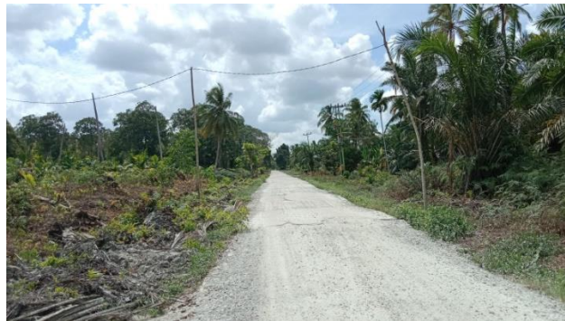
Gambar 1.1 Kondisi Eksisting Sumber : Dokumentasi lapangan
