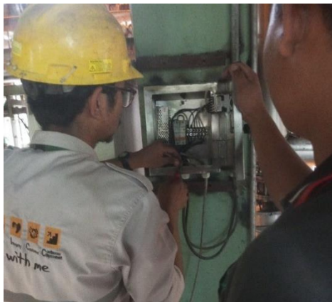
Gambar 3.8. Pemasangan kabel power dan sensor (sumber : dokumentasi penulis 2023)
