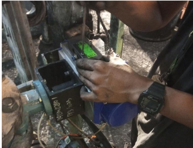
Gambar 2.5. Proses penggantian selenoid valve (sumber : dokumentasi penulis 2023)
