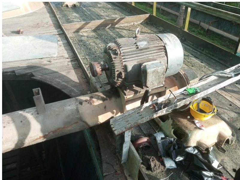
Gambar 2.6. Penggantian Elektromotor di Cooling Tower (Sumber : dokumentasi penulis 2023)
