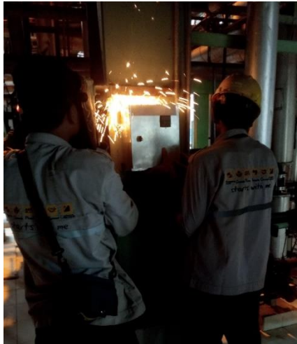
Gambar 3.7. Pengelasan panel (sumber : dokumentasi penulis 2023)
