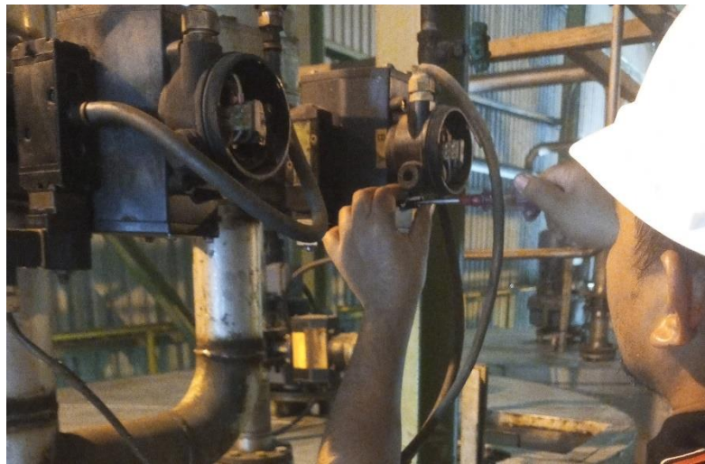
Gambar 2.4. Penggantian Actuator Valve (sumber : dokumentasi penulis 2023)
