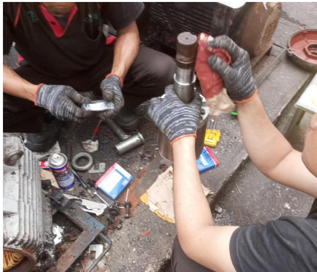
Gambar 2.2. Proses penggantian bearing elektromotor (Sumber : dokumentasi penulis 2023)
