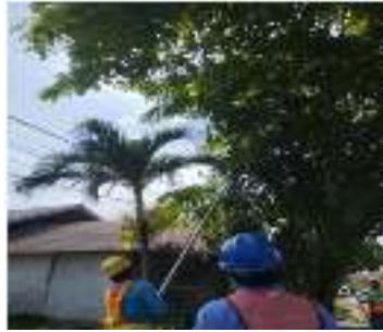
Gambar 2.6 pemangkasan dan pembersihan JTM (Sumber : PT. Adra gemilang, 2023)
