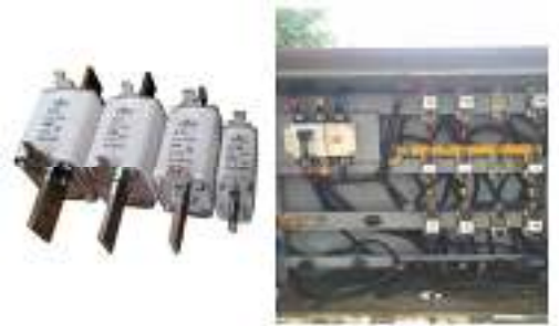
Gambar 3.5. NH Fuse Atau Sekring ( Sumber : PT. Adra gemilang, 2023 )
