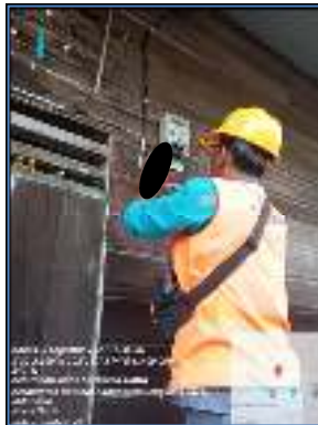
Gambar 2.7 Penggantian MCB (main cercuit breaker) (Sumber : PT. Adra gemilang, 2023)
