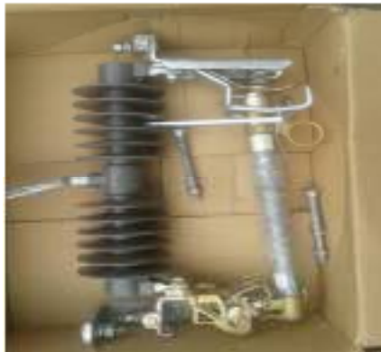
Gambar 2.5 mengganti fuse link dan tabung holder FCO
