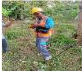
Gambar 2.18 Perbaikan Kabel ( Sumber : PT. Adra gemilang, 2023 )
