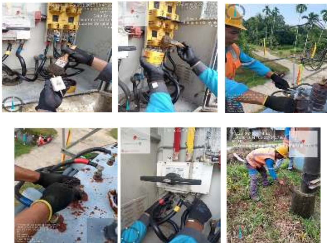
Gambar 3.10. Pemeliharaan PHB-TR (Perangkat Hubung Bagi Tegangan Rendah) ( Sumber : PT. Adra gemilang, 2023)
