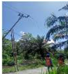
Gambar 2.2 perbaikan tiang dan Saluran kabel udara (SKU) yang kendor.
