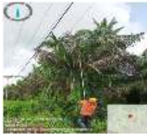
Gambar 2.3 Pemangkasan jaringan tegangan menengah (JTM) (Sumber : PT. Adra gemilang, 2023)
