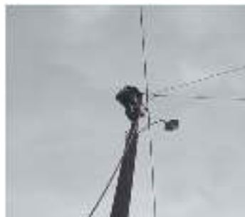
Gambar 2.13 perbaikan kabel SR
