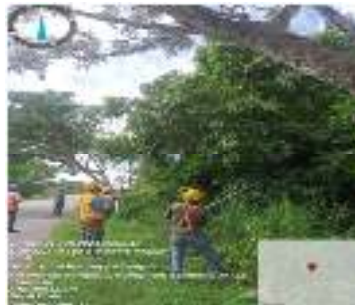
Gambar 2.9 pemangkasan atau pembersihan JTM ( Sumber : PT. Adra gemilang, 2023)
