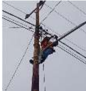
Gambar 2.14 perbaikan kabel SR ( Sumber : PT. Adra gemilang, 2023)
