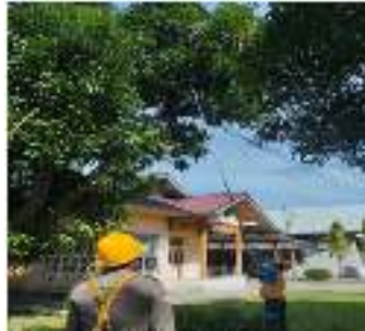
Gambar 2.8 Pemangkasan JTM ( Sumber : PT. Adra gemilang, 2023)
