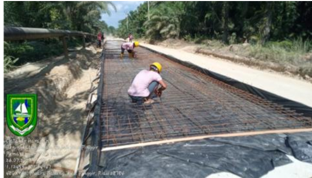
Gambar 3.14 Pekerjaan Pembesian/Tulangan Rigid Sumber: Dokumentasi lapangan, 2023
