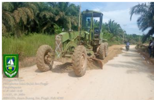
Gambar 3.2 Perataan agregat kelas B Sumber: Dokumentasi lapangan, 2023
