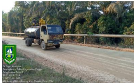
Gambar 3.4 Penyiraman agregat kelas B Sumber: Dokumentasi lapangan, 2023
