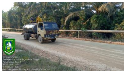
Gambar 4.10 Penyiraman agregat kelas B
