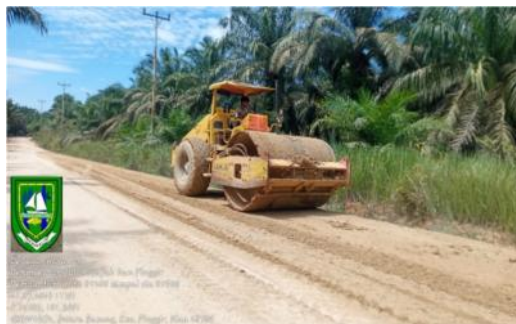
Gambar 4.9 Pemasatan agregat kelas B Sumber: Dokumentasi lapangan, 2023
