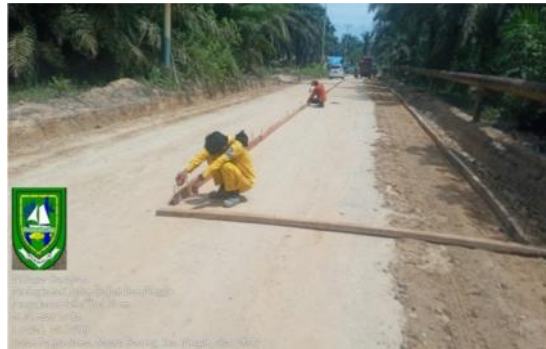
Gambar 3.7 Pemasangan Bekisting Lantai Kerja Sumber: Dokumentasi lapangan, 2023
