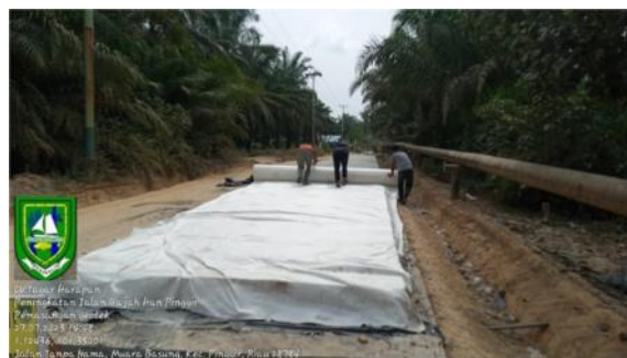
Gambar 3.19 Pekerjaan Pemasangan Geotek Sumber: Dokumentasi lapangan, 2023
