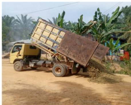
Gambar 3.1 Penghambaran agregat kelas B Sumber: Dokumentasi lapangan, 2023
