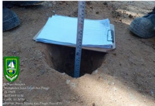
Gambar 4.11 Pengujian Test Pit Sumber: Dokumentasi lapangan, 2023
