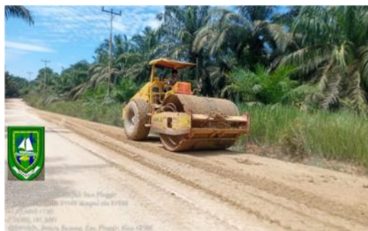
Gambar 3.3 Pemadatan agregat kelas B Sumber: Dokumentasi lapangan, 2023
