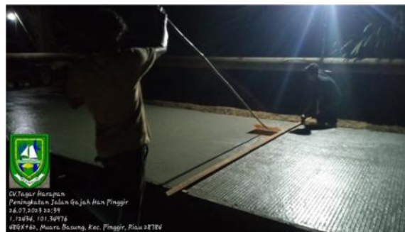
Gambar 3.18 Pekerjaan Grooving Sumber: Dokumentasi lapangan, 2023
