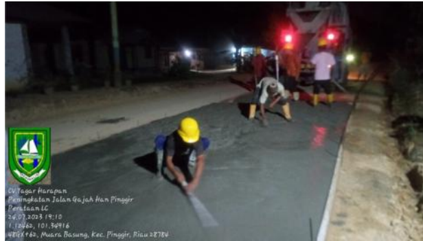
Gambar 3.11 Penghamparan dan Perataan Beton LC Sumber: Dokumentasi lapangan, 2023
