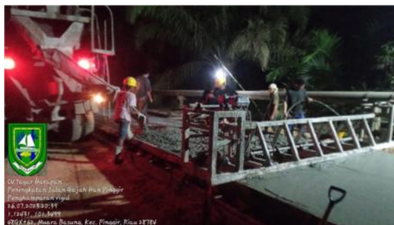
Gambar 3.17 Pekerjaan Penghamparan dan Perataan Beton Rigid Sumber: Dokumentasi lapangan, 2023
