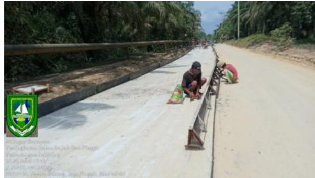
Gambar 3.12 Pengukuran dan pemasangan bekisting Sumber: Dokumentasi lapangan, 2023
