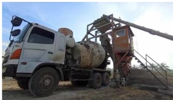
Gambar 3.15 Proses Produksi beton rigid di Batching Plant Sumber: Dokumentasi lapangan, 2023
