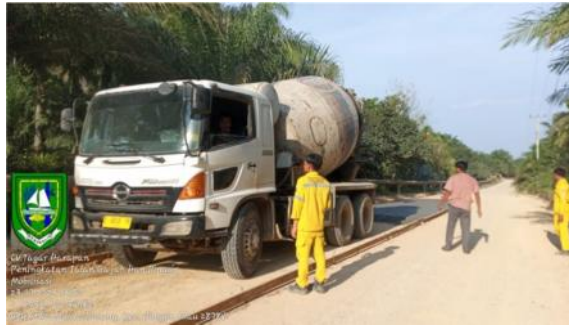
Gambar 3.16 Mobilisasi Beton Rigid Ke Lokasi Pekerjaan Sumber: Dokumentasi lapangan, 2023
