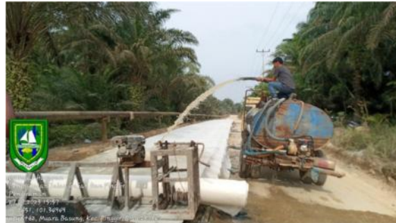
Gambar 3.20 Pekerjaan Penyiraman Rigid Sumber: Dokumentasi lapangan, 2023
