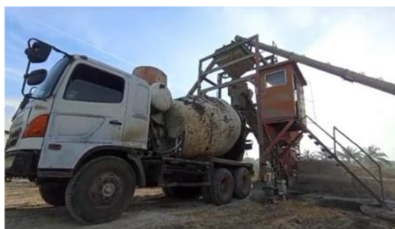
Gambar 3.8 Proses Produksi di Batching Plant Sumber: Dokumentasi lapangan, 2023
