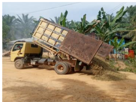
Gambar 4.7 Penghamparan agregat kelas B Sumber: Dokumentasi lapangan, 2023
