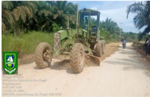
Gambar 4.8 Perataan agregat kelas B Sumber: Dokumentasi lapangan, 2023
