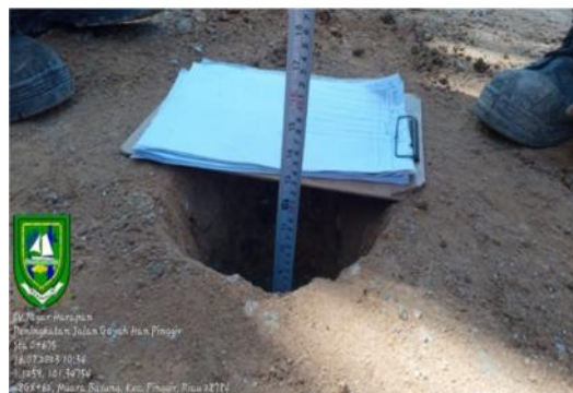
Gambar 3.5 Test Pit agregat kelas B Sumber: Dokumentasi lapangan, 2023
