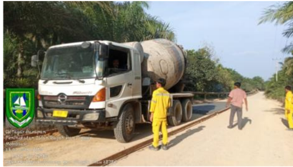
Gambar 3.9 Mobilisasi LC ke lokasi pekerjaan Sumber: Dokumentasi lapangan, 2023
