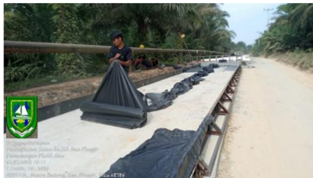
Gambar 3.13 Pemasangan plastik alas dan pematokan Sumber: Dokumentasi lapangan, 2023
