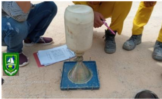
Gambar 4.12 Pengujian sand cone pada lapisan base B Sumber: Dokumentasi lapangan, 2023
