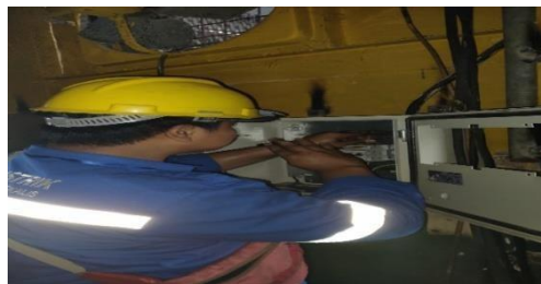
Gambar 2. 22 Pemasangan Stop Kontak (Sumber: Dokumentasi di PT. Indah Kiat Pulp and Paper)
