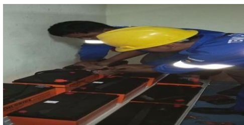
Gambar 2. 1 Perakitan Dan Pemasangan Plat Dan Betri (Sumber: Dokumentasi di PT. Indah Kiat Pulp and Paper)
