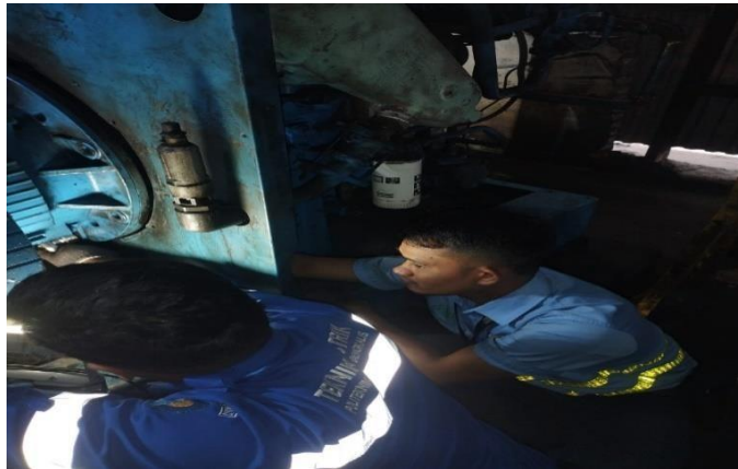
Gambar 2. 33 Ganti Motor Compressor (Sumber: Dokumentasi di PT. Indah Kiat Pulp and Paper)
