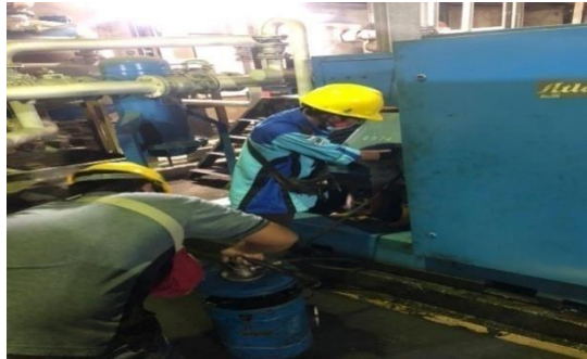
Gambar 2. 21 Penambahan Gris Pada Motor Compressor PG 2 (Sumber: Dokumentasi di PT. Indah Kiat Pulp and Paper)
