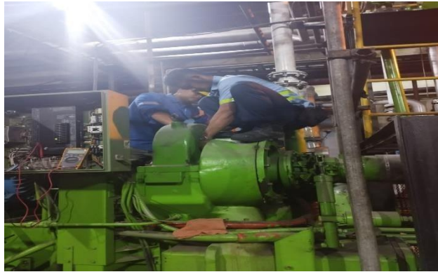
Gambar 2. 11 Membantu Pemasangan Sensor Febrasi (Sumber: Dokumentasi di PT. Indah Kiat Pulp and Paper)
