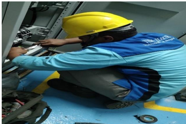
Gambar 2.5 Memasang Dudukan Breaker Dan MCB (Sumber: Dokumentasi di PT. Indah Kiat Pulp and Paper)
