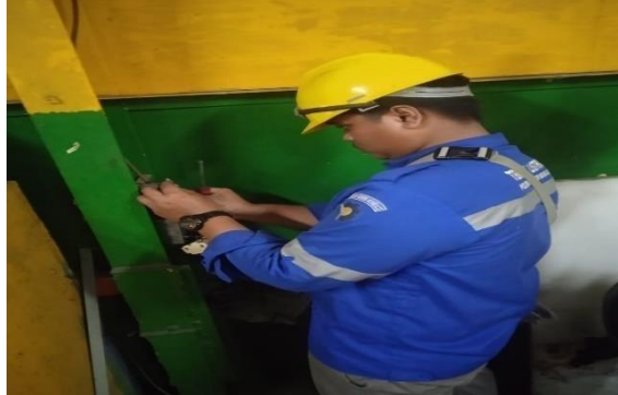
Gambar 2. 44 Pemasangan Stop Kontak (Sumber: Dokumentasi di PT. Indah Kiat Pulp and Paper)
