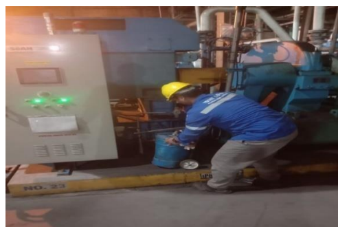
Gambar 2. 23 Penambahan Gris Pada Compressor (Sumber: Dokumentasi di PT. Indah Kiat Pulp and Paper)
