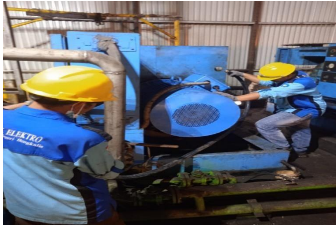
Gambar 2. 34 Tarik Kabel Powwer Compressor (Sumber: Dokumentasi di PT. Indah Kiat Pulp and Paper)
