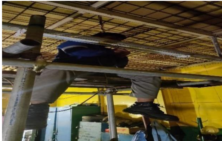
Gambar 2. 18 Pemasangan Lampu LID 220V (Sumber: Dokumentasi di PT. Indah Kiat Pulp and Paper)
