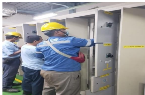
Gambar 2. 8 Membantu Pembersihan Area Shut Down (Sumber: Dokumentasi di PT. Indah Kiat Pulp and Paper)
