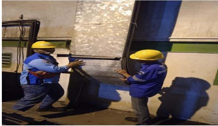
Gambar 2. 9 Membantu Pemasangan Kabel Control Trafo (Sumber: Dokumentasi di PT. Indah Kiat Pulp and Paper)
