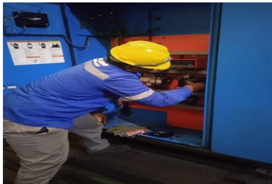
Gambar 2. 43 Pasang Modul Compressor (Sumber: Dokumentasi di PT. Indah Kiat Pulp and Paper)
