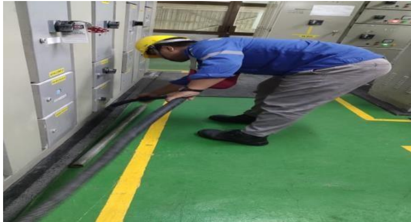
Gambar 2. 17 Pembersihan MCC ROOM PG 2 (Sumber: Dokumentasi di PT. Indah Kiat Pulp and Paper)
