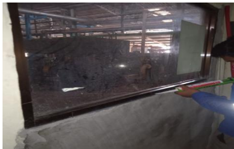
Gambar 2. 47 Shel jendela (Sumber: Dokumentasi di PT. Indah Kiat Pulp and Paper)
