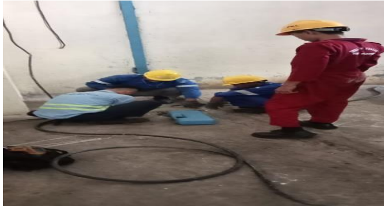
Gambar 2. 2 Memasang Kabel Power DC (Sumber: Dokumentasi di PT. Indah Kiat Pulp and Paper)
