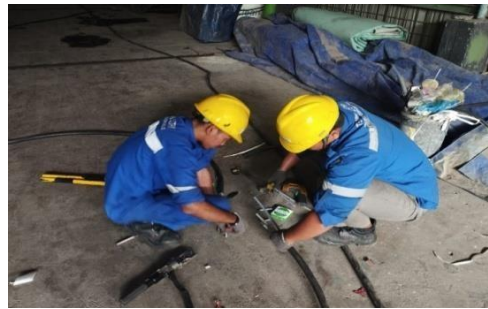
Gambar 2. 7 Menarik Kabel Power Dan Penyambungan (Sumber: Dokumentasi di PT. Indah Kiat Pulp and Paper)
