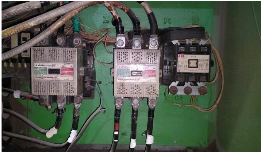
Gambar 4. 5 Kontaktor (K Utama, K start, K Delta) (Sumber: Dokumentasi di PT. Indah Kiat Pulp And Paper)
