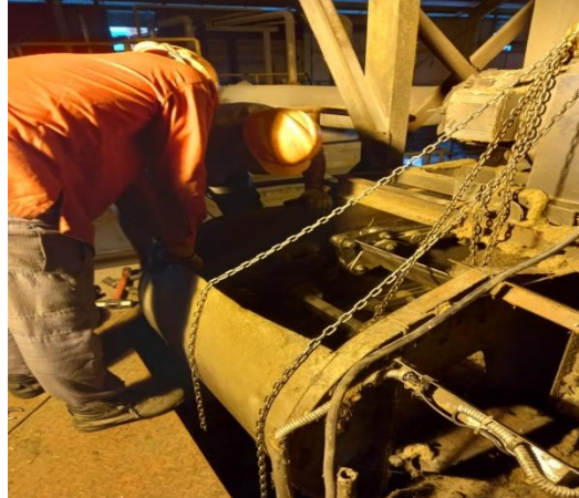
Gambar 3. 5 penggantian rantai conveyor (Sumber : Dokumentasi penulis)
