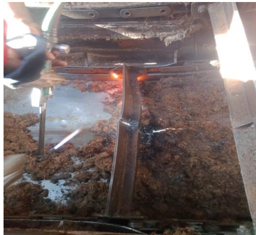
Gambar 3. 6 Pemotongan scraper yang bengkok (Sumber : Dokumentasi Penulis)
