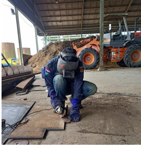
Gambar 4. 11 Mengerinda bagian yang tajam atau tidak rapi
