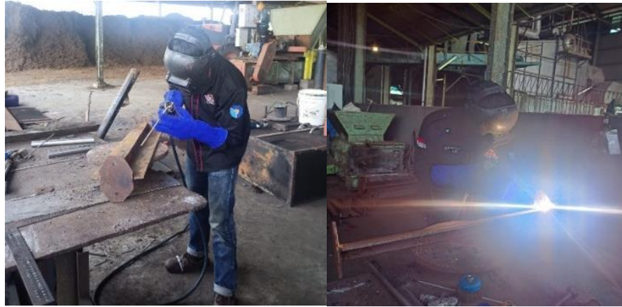
Gambar 4. 13 Mengelas komponen scraper conveyor
