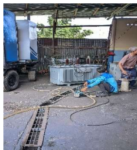
Gambar 2.19 Pembersihan dan Pemindahan Sisa Minyak Trafo (Sumber : Dokumentasi 2023)
