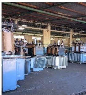
Gambar 2.38 Proses Penirisan Sisa Minyak Trafo (Sumber : Dokumentasi 2023)
