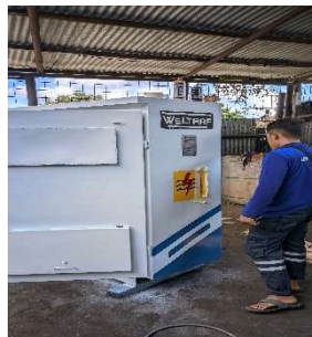
Gambar 2.6 Pengecatan Box Panel UGB (Sumber : Dokumentasi 2023)
