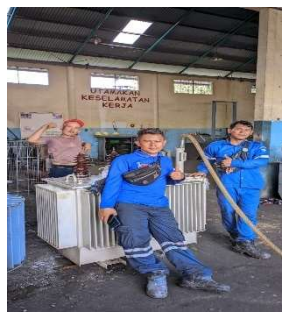
Gambar 2.56 Flushing Minyak Trafo (Sumber : Dokumentasi 2023)
