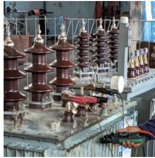
Gambar 4.18 Pengujian dengan Metode Inject (Sumber : Dokumentasi 2023)
