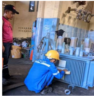
Gambar 4.20 Pengecatan Bodi Trafo (Sumber : Dokumentasi 2023)
