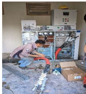
Gambar 2.2 Penggantian Kubikel Di Gardu Hubung PT HKL (Sumber : Dokumentasi 2023)
