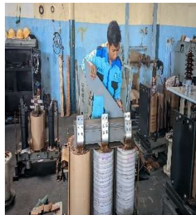
Gambar 2.40 Pemasangan Inti Besi (Sumber : Dokumentasi 2023)
