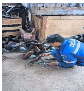
Gambar 2.63 Perakitan Hang Isolator (Sumber : Dokumentasi 2023)
