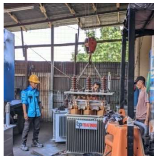
Gambar 4.13 Proses Memasukkan Komponen Dalam Trafo Kedalam Tangki Trafo (Sumber : Dokumentasi 2023)
