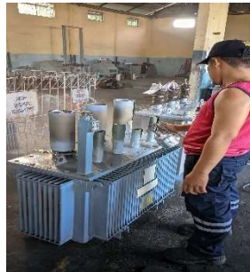
Gambar 2.12 Repaint Body Trafo (Sumber : Dokumentasi 2023)
