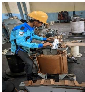
Gambar 2.32 Pemasangan Inti Besi Trafo (Sumber : Dokumentasi 2023)
