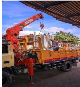
Gambar 2.33 Muat Trafo dengan Truk Crane (Sumber : Dokumentasi 2023)
