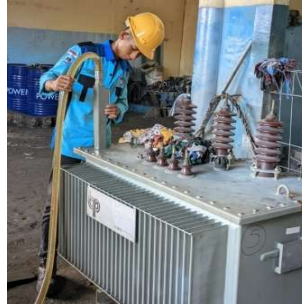
Gambar 4.16 Memasukkan Minyak Kedalam Tangki Trafo (Sumber : Dokumentasi 2023)
