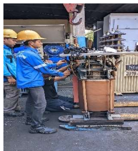
Gambar 2.15 Perakitan Komponen Trafo (Sumber : Dokumentasi 2023)
