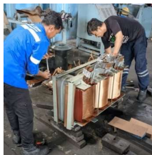
Gambar 4.9 Pemasangan Kerangka Trafo (Sumber : Dokumentasi 2023)
