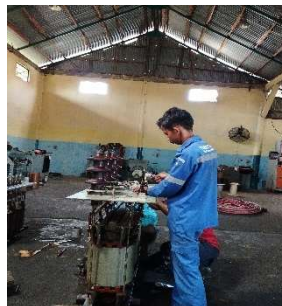
Gambar 2.9 Perakitan Bushing TR (Sumber : Dokumentasi 2023)
