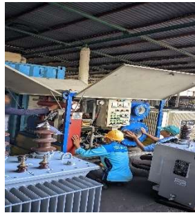
Gambar 2.24 Perawatan Mesin Flushing (Sumber : Dokumentasi 2023)
