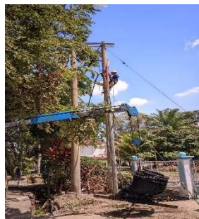
Gambar 2.47 Pemasangan SKU TR (Sumber : Dokumentasi 2023)
