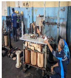
Gambar 2.28 Perakitan Kerangka Trafo (Sumber : Dokumentasi 2023)
