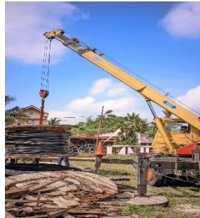
Gambar 2.52 Pemotongan Kabel MVTIK (Sumber : Dokumentasi 2023)
