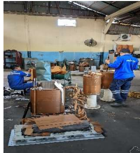
Gambar 2.35 Pembongkaran Trafo (Sumber : Dokumentasi 2023)
