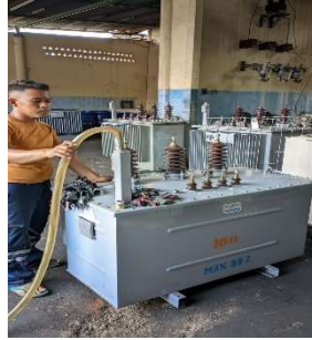
Gambar 2.48 Flushing Minyak Trafo (Sumber : Dokumentasi 2023)
