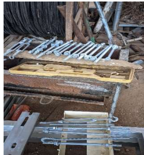
Gambar 2.49 Baut dan Mur yang telah di Cat (Sumber : Dokumentasi 2023)
