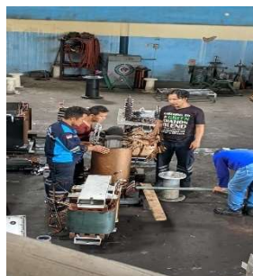
Gambar 2.46 Pembongkaran Trafo (Sumber : Dokumentasi 2023)
