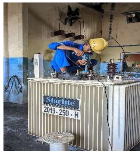
Gambar 2.23 Penyikatan Bushing Trafo (Sumber : Dokumentasi 2023)
