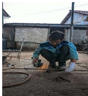
Gambar 2.57 Pemotongan Besi (Sumber : Dokumentasi 2023)
