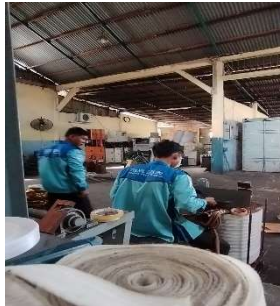
Gambar 2.37 Pemasangan Inti Besi Trafo (Sumber : Dokumentasi 2023)
