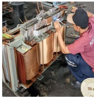
Gambar 4.10 Pengelasan Busbar Tembaga Jalur TR (Sumber : Dokumentasi 2023)
