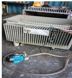
Gambar 2.13 Pembersihan dan Pemindahan Sisa Minyak Trafo (Sumber : Dokumentasi 2023)
