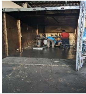
Gambar 2.29 Memasukkan Trafo Kedalam Oven Pemanas (Sumber : Dokumentasi 2023)
