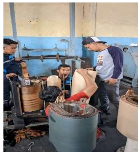
Gambar 2.51 Pemasangan Penampang Kumparan (Sumber : Dokumentasi 2023)
