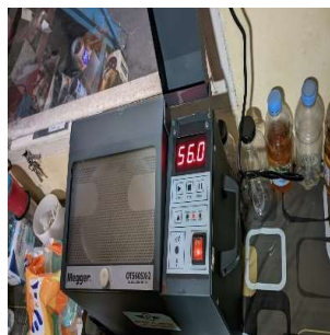
Gambar 4.15 Pengujian Tegangan Tembus Minyak Trafo (Sumber : Dokumentasi 2023)
