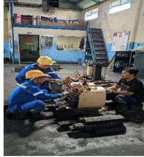
Gambar 2.27 Pemasangan Inti Besi (Sumber : Dokumentasi 2023)
