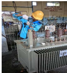
Gambar 2.22 Penyikatan Bushing Trafo (Sumber : Dokumentasi 2023)
