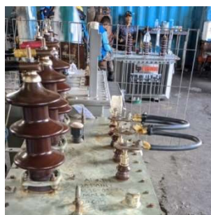
Gambar 4.19 Pengujian Beban Penuh (Sumber : Dokumentasi 2023)
