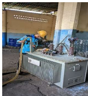
Gambar 2.21 Flushing Minyak Trafo (Sumber : Dokumentasi 2023)
