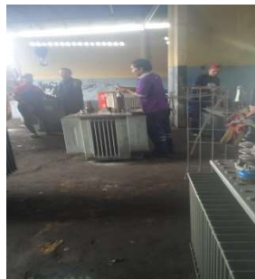
Gambar 2.54 Pemasangan Short TR untuk Uji Beban Penuh Trafo (Sumber : Dokumentasi 2023)
