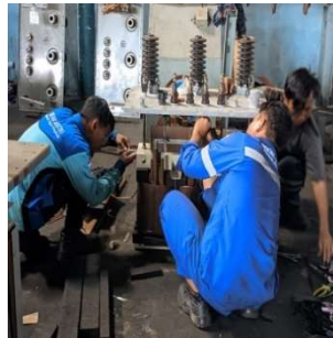
Gambar 4.4 Pembongkaran Kerangka Trafo (Sumber : Dokumentasi 2023)
