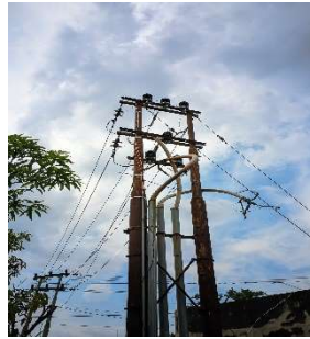
Gambar 2.8 Penggantian Lightning Arrester (Sumber : Dokumentasi 2023)
