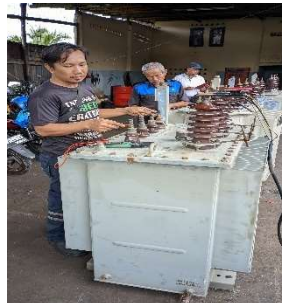
Gambar 2.30 Pengujian Awal Trafo (Sumber : Dokumentasi 2023)
