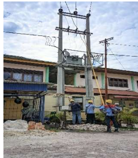
Gambar 2.45 Perawatan Gardu Portal (Sumber : Dokumentasi 2023)
