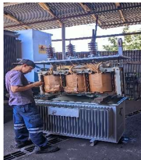
Gambar 2.25 Proses Penirisan Sisa Minyak (Sumber : Dokumentasi 2023)
