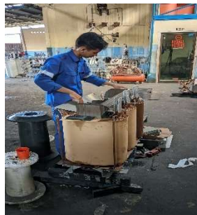
Gambar 2.36 Pemasangan Inti Besi Trafo (Sumber : Dokumentasi 2023)
