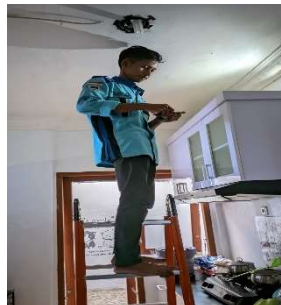
Gambar 2.4 Penggantian dan Pemasangan Instalasi Listrik (Sumber : Dokumentasi 2023)
