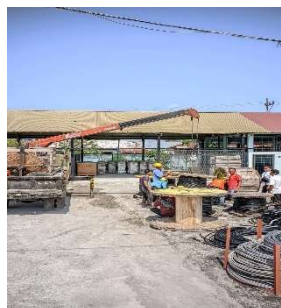
Gambar 2.61 Pengangkatan Kabel Menggunakan Crane (Sumber : Dokumentasi 2023)
