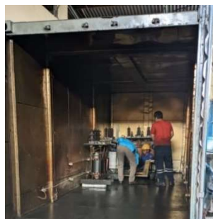
Gambar 4.12 Memasukkan Trafo Kedalam Oven (Sumber : Dokumentasi 2023)
