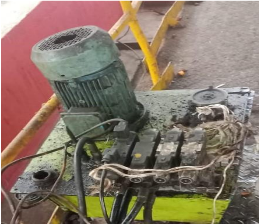
Gambar 3.24 motor pompa hidrolik
