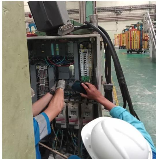
Gambar 2. 25 Gambar penggantian *power supply*
