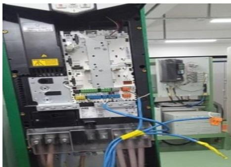
Gambar 2. 20 Gambar Pemasangan Kabel Kontrol Motor
