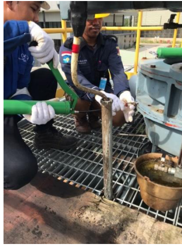
Gambar 3.8 Top Up Greasing (Sumber : Dokumentasi pribadi)
