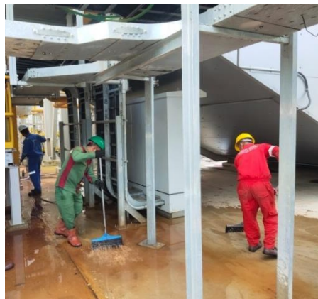
Gambar 3.9 Cleaning HRSG unit 11 (Sumber : Dokumentasi pribadi)
