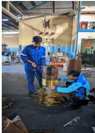
Gambar 2.43. Pembongkaran Lilitan Trafo (sumber : Dokumentasi 2023)
