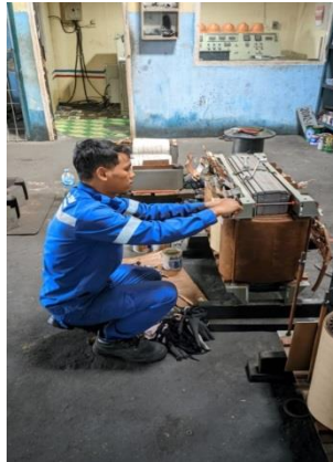
Gambar 2.17. Pemasangan Cor Trafo
