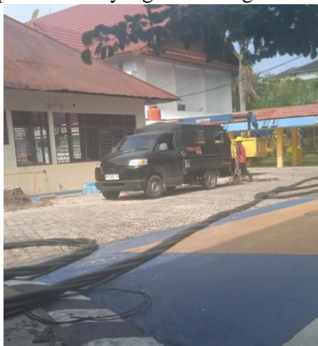
Gambar 2.62. Pemasangan Kabel
