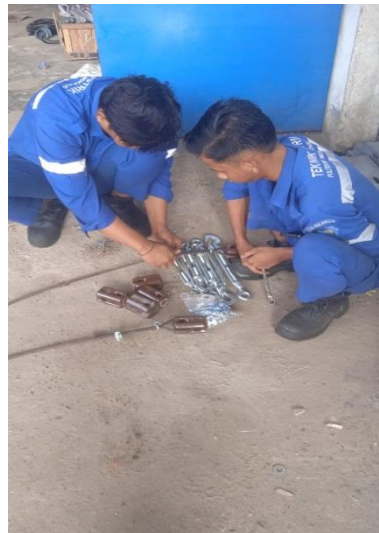
Gambar 2.65. Perakitan Tui Insulator (sumber : Dokumentasi 2023)
