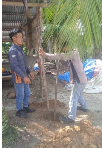
Gambar 2.59. Penggalian Kontruksi Tiang (sumber : Dokumentasi 2023)
