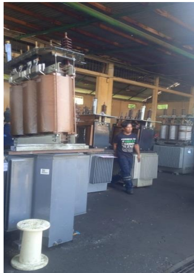
Gambar 2.41. Pembongkaran Trafo (sumber : Dokumentasi 2023)
