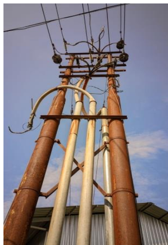
Gambar 2.8. Pemasangan Lightning Arrester
