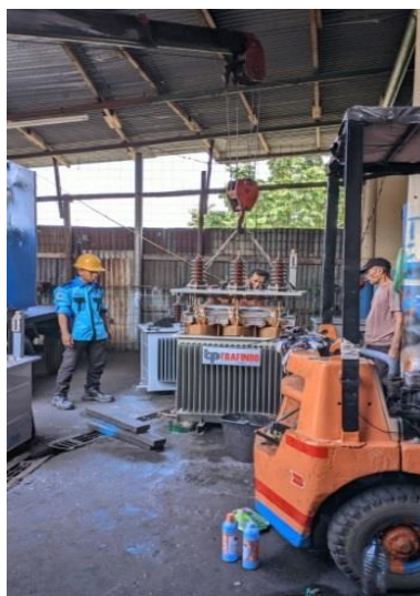
Gambar 2.4. Pembongkaran Trafo (sumber : Dokumentasi 2023)
