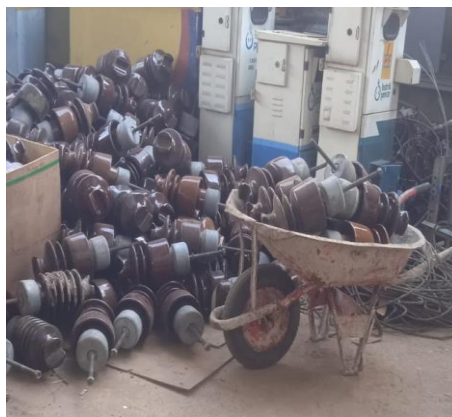
Gambar 2.54. Pemindahan Pin Isolator
