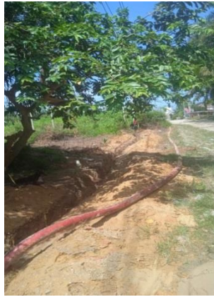
Gambar 2.9. Pemasangan Kabel Tanah
