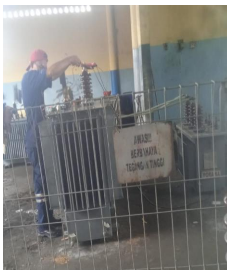
Gambar 2.58. Pengujian Trafo
