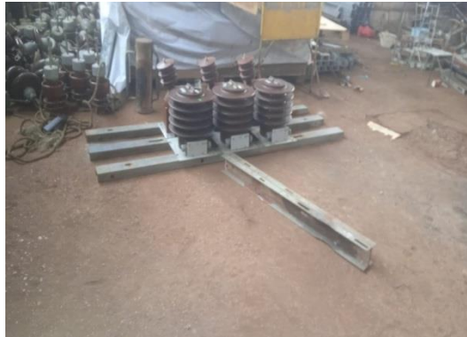
Gambar 2.69. Perakitan Trafo Tegangan Dan Trafo Arus (sumber : Dokumentasi 2023)
