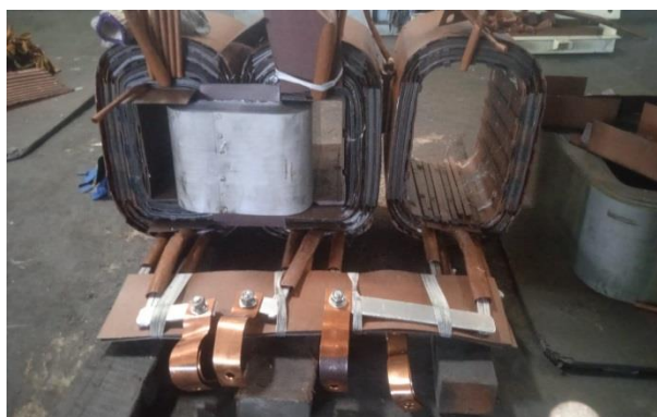
Gambar 2.12. Pembongkaran Lilitan (sumber : Dokumentasi 2023)
