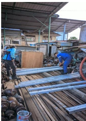
Gambar 2.48. Pengecatan Traves (sumber : Dokumentasi 2023)
