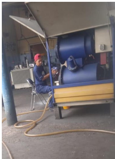
Gambar 2.60. Flushing Minyak Trafo (sumber : Dokumentasi 2023)
