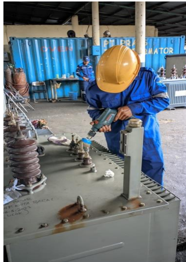
Gambar 2.25. Pembersihan Bussing (sumber : Dokumentasi 2023)
