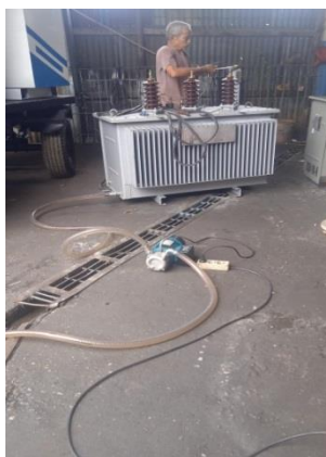
Gambar 2.18. Penyedotan Minyak
