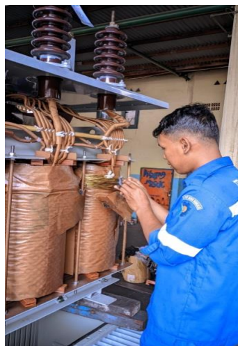
Gambar 2.36. Pengukuran Kawat (sumber : Dokumentasi 2023)
