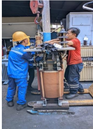
Gambar 2.15. Perakitan Trafo (sumber : Dokumentasi 2023)
