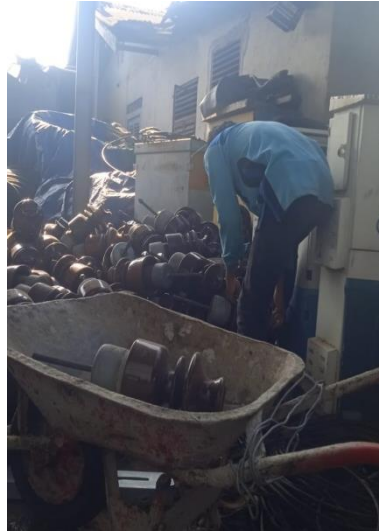
Gambar 2.53. Pemindahan Pin Isolator
