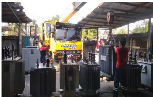
Gambar 2.64. Pembongkaran Trafo (sumber : Dokumentasi 2023)
