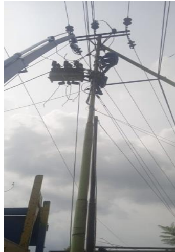
Gambar 2.7. Pemasangan Load Break Switch
