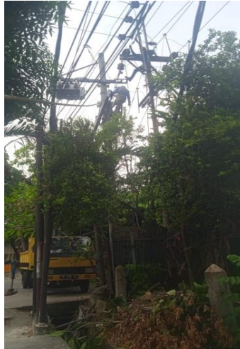
Gambar 2.49. Pemasangan Load Break Switch
