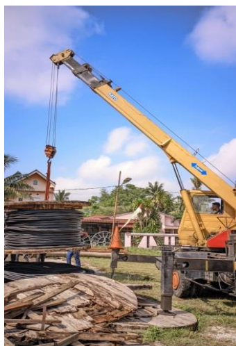
Gambar 2.56. Pembongkaran Kabel MPTIK
