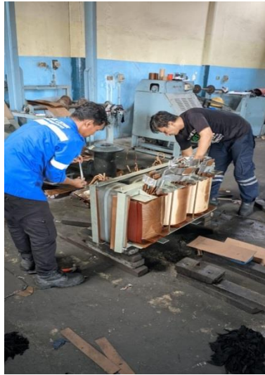
Gambar 2.31. Perakitan Trafo (sumber : Dokumentasi 2023)
