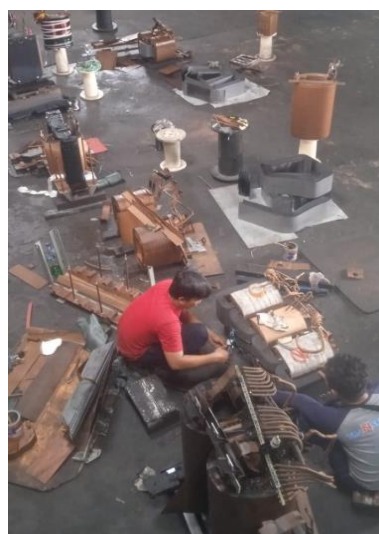
Gambar 2.44. Pemasangan Cor Trafo (sumber : Dokumentasi 2023)
