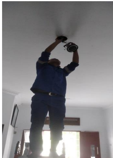
Gambar 2.2. Pemasangan Instalasi Rumah (sumber : Dokumentasi 2023)
