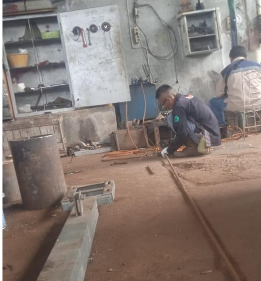
Gambar 2.61. Pemotongan Besi
