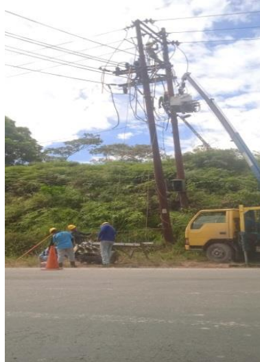
Gambar 2.3. Pemasangan Load Break Switch (sumber : Dokumentasi 2023)
