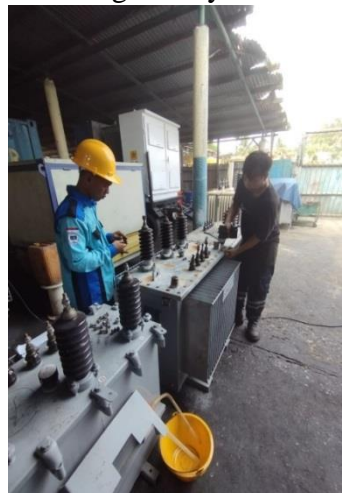
Gambar 2.6. Perakitan Trafo (sumber : Dokumentasi 2023)
