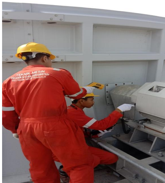
Gambar 3. 3 PM di Cooling Tower (Sumber : Dokumentasi Pribadi)
