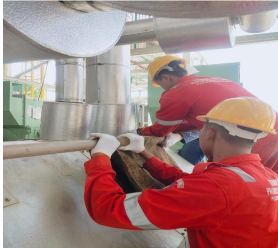
Gambar 3. 8 Perbaikan Pompa Boiler Feedd Pump
