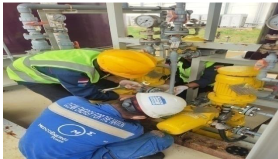
Gambar 3. 7 Perbaikan Pompa NaOCl (Sumber : Dokumentasi Pribadi)
