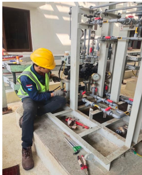
Gambar 3. 9 Perbaikan Pompa Polymer
