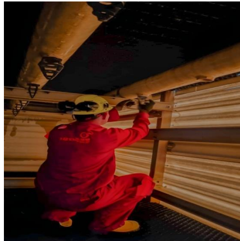
Gambar 4. 17 Pemasangan nozzle baru (sumber :dokumentasi pribadi)
