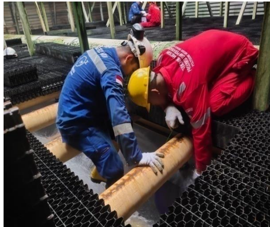
Gambar 4. 16 Pelepasan Nozzle (sumber :dokumentasi pribadi)
