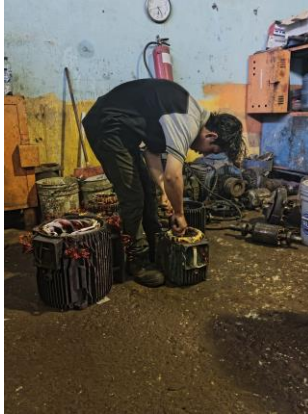
Gambar 2. 39 Memasang kertas prespan untuk elmot konveyor 5,5 Kw Sumber : Dokumentasi pribadi
