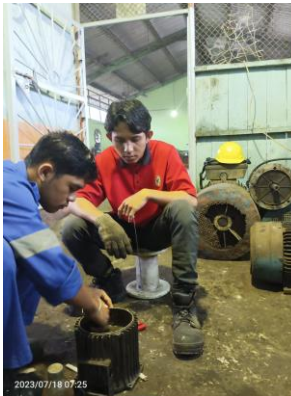
Gambar 2. 32 Memperbaiki elmot konveyor 2,5 Kw Sumber : Dokumentasi pribadi
