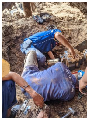
Gambar 2. 40 Perbaikan gear box untuk elmot viber sel Sumber : Dokumentasi pribadi
