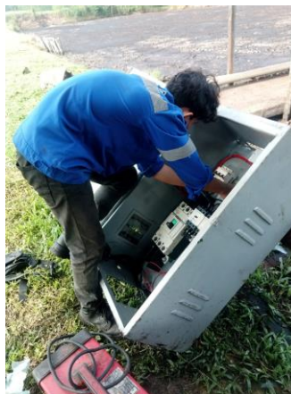
Gambar 2. 68 Mengganti Panel kontrol LA untuk Limbah Sumber : Dokumentasi pribadi
