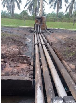
Gambar 3. 19 Saluran Kondensat
