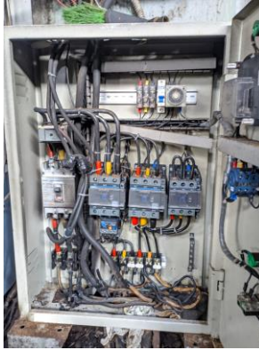
Gambar 2. 31 Memperbaiki kabel panel untuk pressan yang terbakar meleleh Sumber : Dokumentasi pribadi
