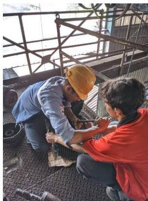
Gambar 2. 16 Mengganti elmot crane Sumber : Dokumentasi pribadi
