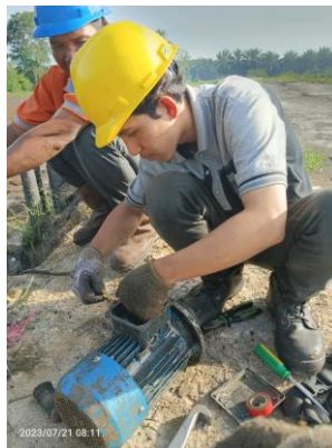
Gambar 2. 34 Memasang elmot pompa pengutipan minyak 1,5 Kw Sumber : Dokumentasi pribadi
