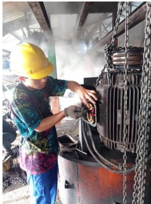
Gambar 2. 64 Menghubungkan terminal kabel elmot gester Sumber : Dokumentasi pribadi
