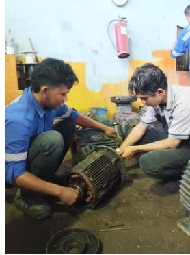
Gambar 2.21 Membongkar elmot konveyor Sumber : Dokumentasi pribadi
