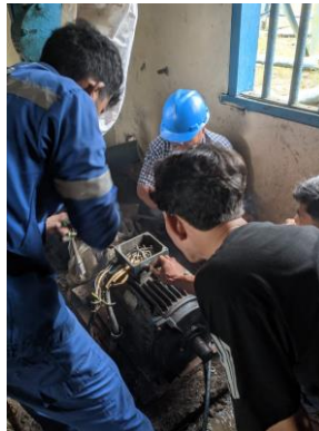
Gambar 2. 54 Menyambung kabel pompa treatment water Sumber : Dokumentasi pribadi
