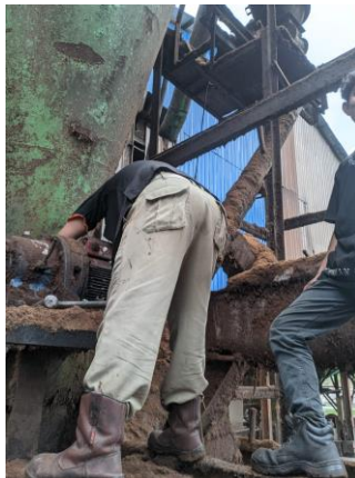
Gambar 2. 56 Memasang elmot vibershell. Sumber : Dokumentasi pribadi
