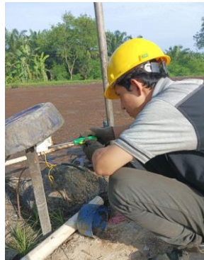
Gambar 2. 42 Mengecek arus untuk pump pengutipan yang hilang 1phasanya Sumber : Dokumentasi pribadi
