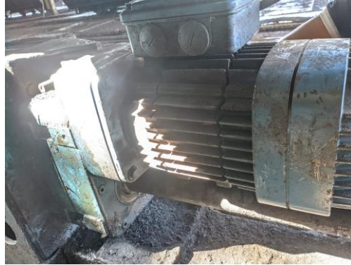
Gambar 2. 41 Perbaikan SPI elmot crane Sumber : Dokumentasi pribadi
