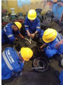
Gambar 2. 1 Mengcouple elmot 7,5 Kw Sumber : Dokumentasi pribadi
