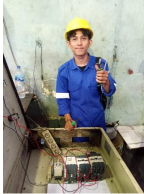
Gambar 2. 7 Merangkai rangkaian StarDelta Sumber : Dokumentasi pribadi
