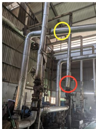
Gambar 4. 8 Pipa Saluran Masuk ke Turbin dan Pipa Masuk ke BPV
