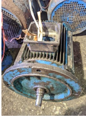
Gambar 2. 29 Merakit elmot 5,5 Kw untuk konveyor Sumber : Dokumentasi pribadi
