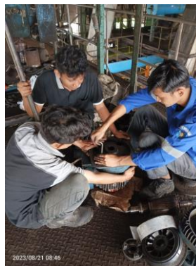
Gambar 2. 60 Memasang elmot crane turun naik dan mengganti gearboxnya Sumber : Dokumentasi pribadi
