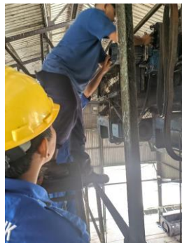
Gambar 2. 18 Mengganti elmot crane terbakar Sumber : Dokumentasi pribadi
