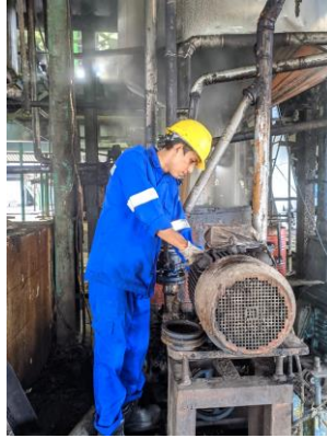
Gambar 2. 25 Perbaikan Drain Tank Pump Sumber : Dokumentasi pribadi
