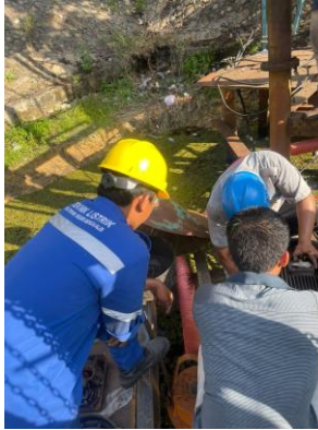
Gambar 2.19 Mengganti elmot waduk Sumber : Dokumentasi pribadi
