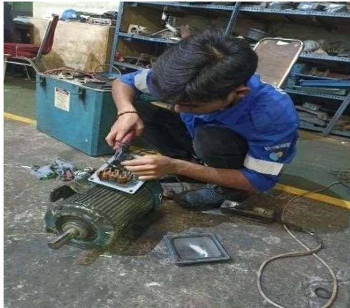
Gambar 2. 12 Pemasangan terminal
