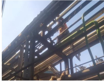
Gambar 2. 11Welding Pipa Steam (sumber: dokumentasi pribadi)
