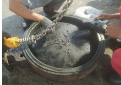
Gambar 2. 13 Repair Valve (sumber: dokumentasi pribadi)
