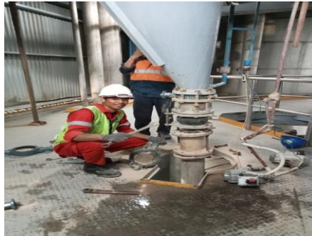
Gambar 2. 18 Repair Dosing Bleaching (sumber: dokumentasi pribadi)
