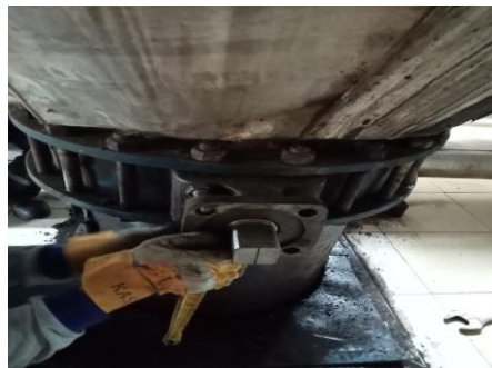
Gambar 2. 16 Repair Niagara (sumber: dokumentasi pribadi)
