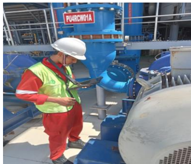
Gambar 2. 10 PM Pengecekan dan Pengambilan data Pompa (sumber: dokumentasi pribadi)
