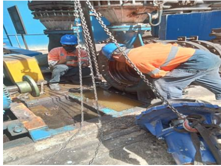
Gambar 2. 15 Repair Pompa Dirty (sumber: dokumentasi pribadi)
