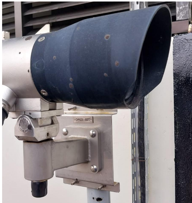
Gambar 3.5 Unit pengirim IR5500 pada area CDU
