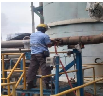
Gambar 2. 25 Pembersihan Pipa Akibat Penumpukan Pulp di FL2.
