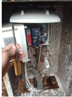
Gambar 2. 20 Menghidupkan Transmitter Consistency di FL8 (Sumber : Dokumentasi PT. Indah Kiat pulp & paper Tbk Perawang, 2023)
