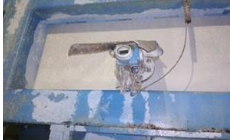
Gambar 3. 5 Bentuk fisik dari Level Transmitter
