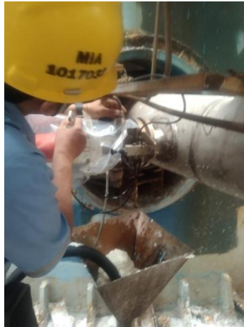
Gambar 2. 38 Pemasangan Pipa Besi Pada Sample Point di PM8
