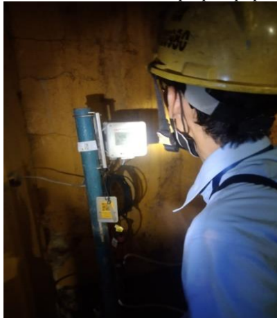
Gambar 2. 34 Perbaikan sensor PH meter di Lapangan (Sumber : Dokumentasi PT. Indah Kiat pulp & paper Tbk Perawang, 2023)
