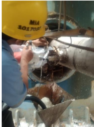
Gambar 2. 37 Pemasangan pipa besi pada sample point di PM8 (Sumber : Dokumentasi PT. Indah Kiat pulp & paper Tbk Perawang, 2023)
