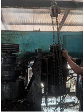
gambar 2. 6 4 Mengganti elmot dighester (Sumber: PTPN V SEI BUATAN )
