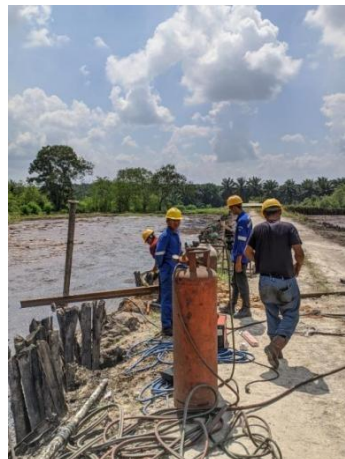
gambar 2.1 5 Pemasangan pompa (Sumber: PTPN V SEI BUATAN )
