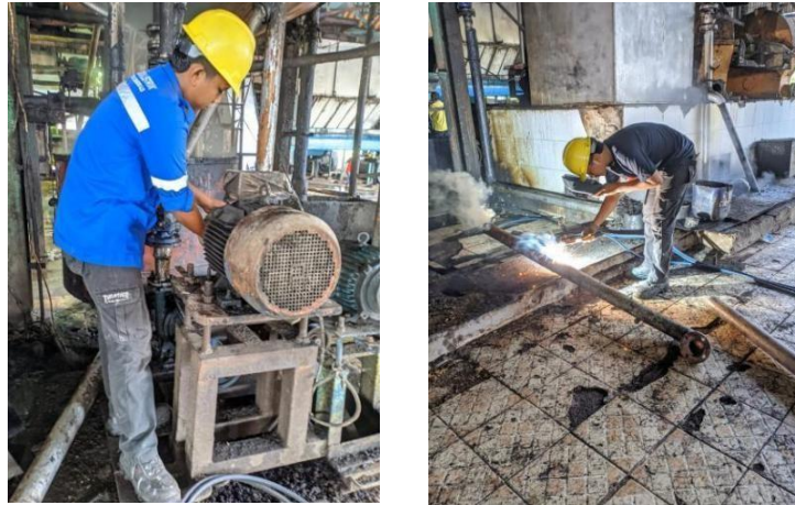
gambar 2.2 8 Perbaikan drain tanki pamp 2 (Sumber: PTPN V SEI BUATAN )
