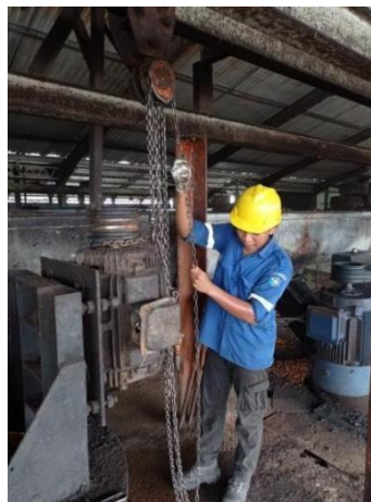
gambar 2.2 9 Pemasangan elmot (Sumber: PTPN V SEI BUATAN )
