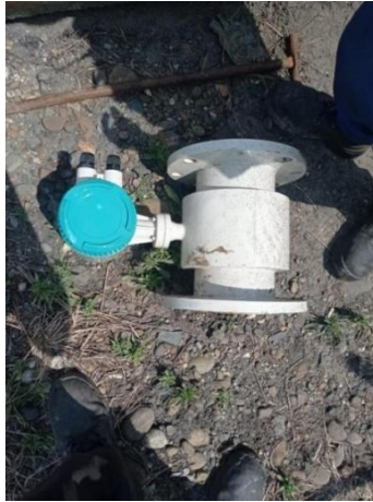
gambar 2.1 6 Pemindahan flowmeter (Sumber: PTPN V SEI BUATAN )
