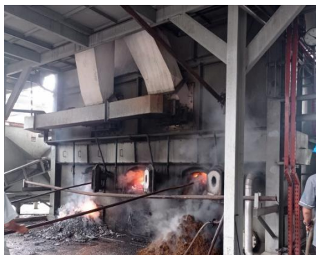
gambar 4. 4 Ruang bakar ( sumber : PTPN V SEI BUATAN )
