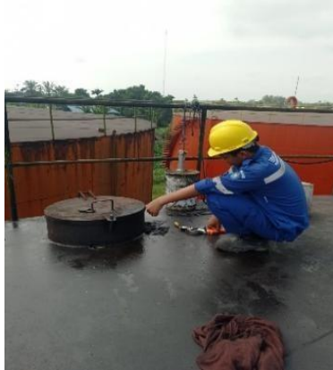
gambar2. 8 Penggantian tutup menhul dan mengganti elmot (Sumber: PTPN V SEI BUATAN )
