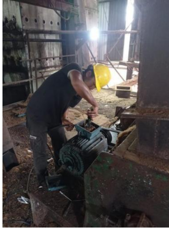
gambar 2. 3 5 Mengganti elmot (Sumber: PTPN V SEI BUATAN )
