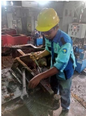
gambar 2.1 3 Perbaikan gearboks (Sumber: PTPN V SEI BUATAN )
