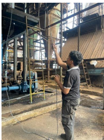
gambar 2. 5 0 Mengganti elmot (Sumber: PTPN V SEI BUATAN )
