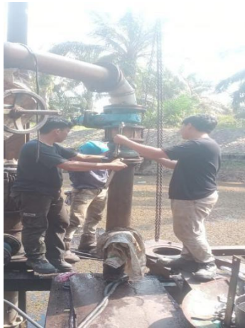
gambar 2. 4 8 Memasang elmot (Sumber: PTPN V SEI BUATAN )
