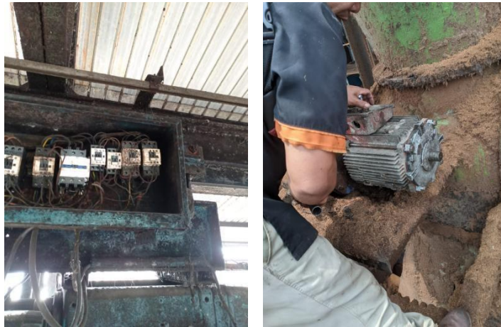
gambar 2. 5 6 Memperbaiki kontaktor dan mengganti elmot (Sumber: PTPN V SEI BUATAN )
