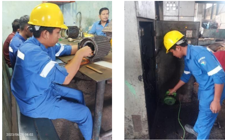
gambar 2.1 4 Pemasangan lilitan elmot dan pembersihan panel control (Sumber: PTPN V SEI BUATAN)
