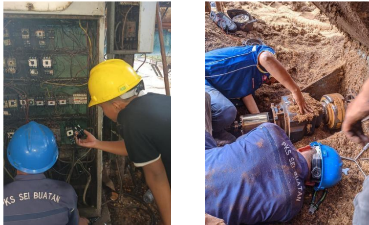
gambar 2. 4 1 Mengganti kontaktor dan mengganti gearboks (Sumber: PTPN V SEI BUATAN )
