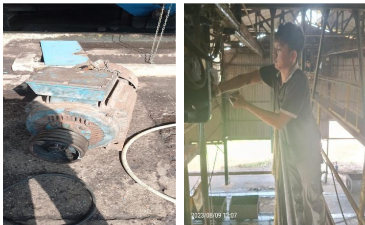
gambar 2. 5 1 Menurunkan elmot dan mengganti elmot (Sumber: PTPN V SEI BUATAN )
