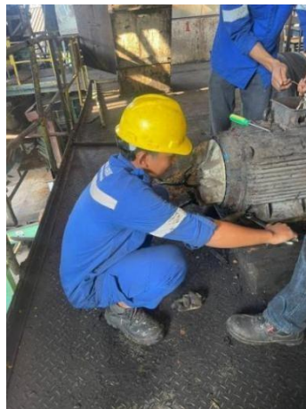
gambar 2. 3 1 Pemasangan elmot (Sumber: PTPN V SEI BUATAN )
