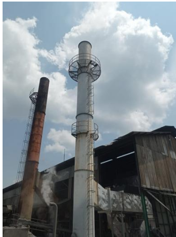
gambar 4. 6 Cerobong Asap ( sumber : PTPN V SEI BUATAN )
