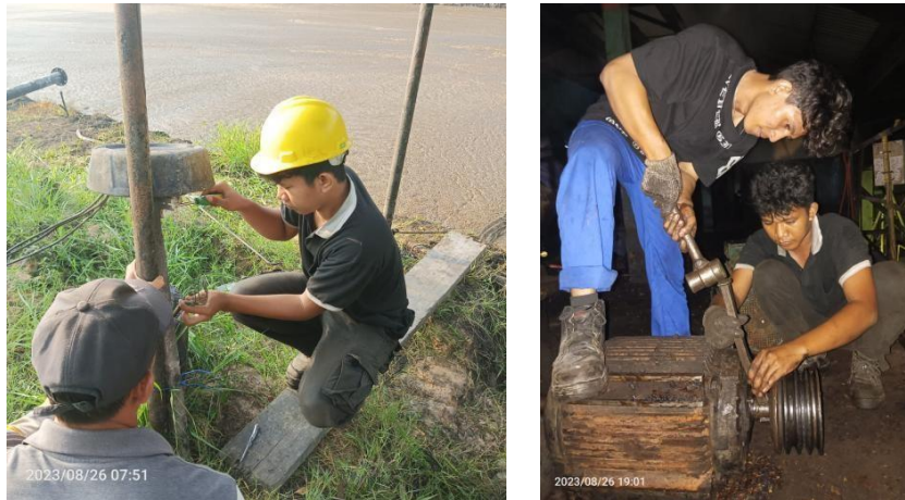
gambar 2. 6 6 Memasang kabel pompa dan mengganti elmot (Sumber: PTPN V SEI BUATAN )
