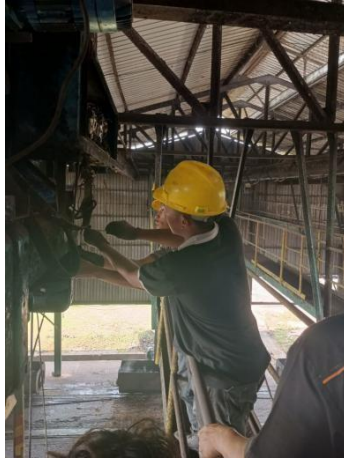
gambar 2. 4 3 Mengganti elmot hosting crane (Sumber: PTPN V SEI BUATAN )
