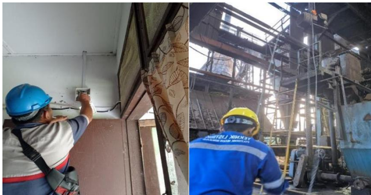
gambar2. 3 Pemasangan elmot dan perbaikan instalasi (Sumber: PTPN V SEI BUATAN )
