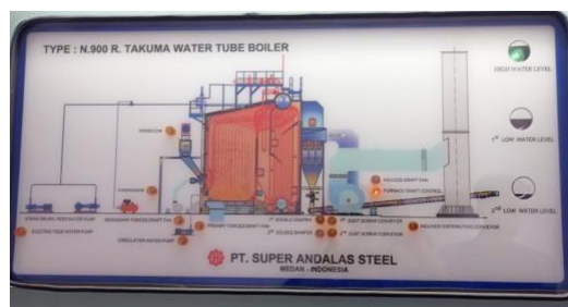
gambar 4. 2 Siklus kerja boiler ( sumber : PTPN V SEI BUATAN )
