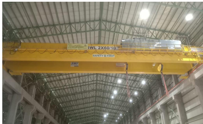
Gambar 4. 7 Jembatan palang Sumber : Hasil dokumentasi sendiri
