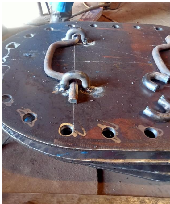
Gambar 4.7 pengelasan gagang manhole Sumber : Dokumentasi sendiri
