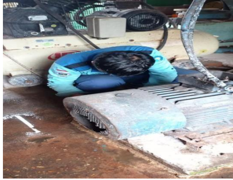
Gambar 2. 47 Memasang Elmot WTP
