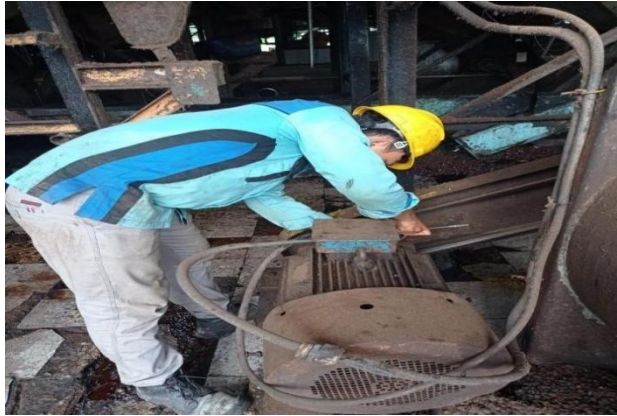
Gambar 2. 38 Memperbaiki Elmot Stasiun Biji
