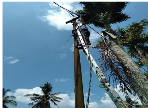
Gambar 2. 15 Melepas Kabel Duplex
