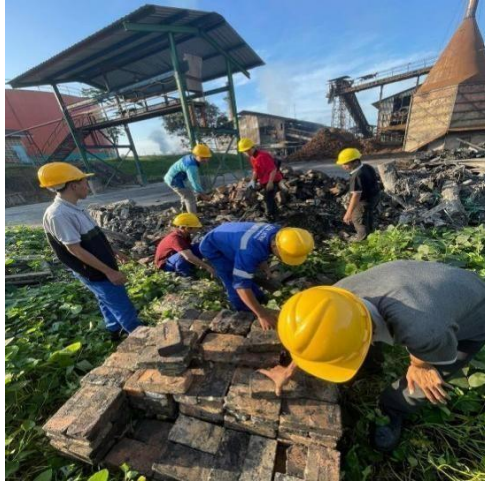
Gambar 2. 12 Menyusun Batu Bekas Bongkaran Boiler
