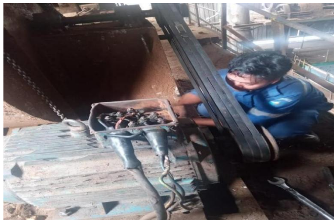
Gambar 2. 52 Memperbaiki Elmot Blower
