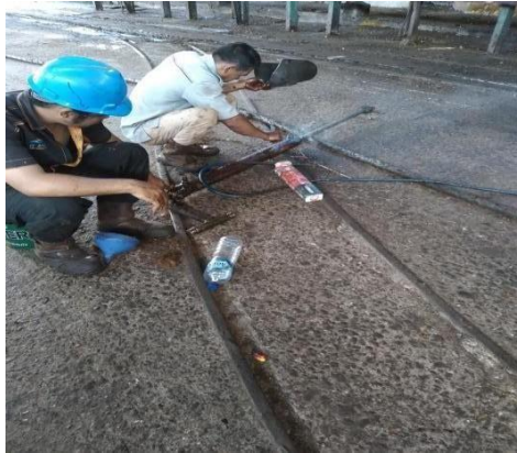
Gambar 2. 14 Memperbaiki Rel Gerbong (Sumber: Dokumentasi di PTPN V SEI BUATAN )
