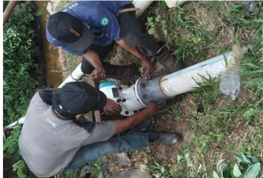
Gambar 2. 16 Memasang Flowmeter
