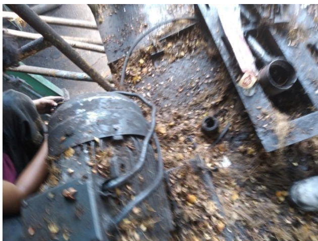
Gambar 2. 37 Memperbaiki Elmot Konveyor
