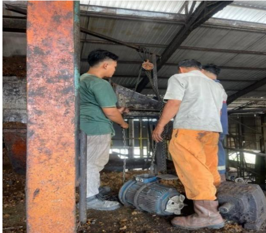
Gambar 2. 53 Memasang Elmot Konveyor (Sumber: Dokumentasi di PTPN V SEI BUATAN )
