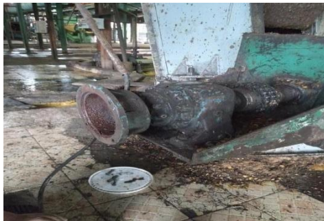
Gambar 2. 39 Memasang Spi Elmot Conveyor
