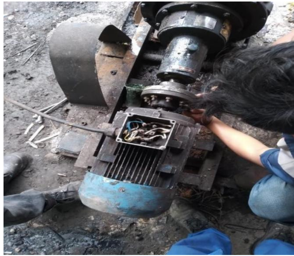
Gambar 2. 63 Memasang Elmot Klarifikasi
