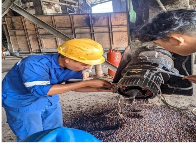
Gambar 2. 34 Memasang Elmot Kernel
