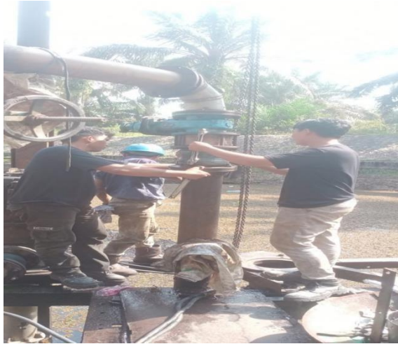
Gambar 2. 49 Memasang Elmot Waduk
