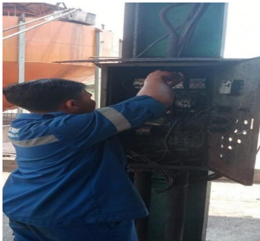
Gambar 2. 65 Memasang MCB
