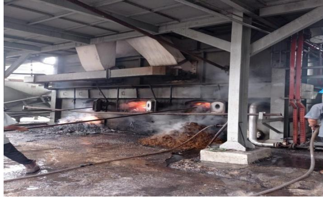
Gambar 2. 3 Pengeluaran Ampas Bakaran Di Boiler
