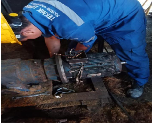
Gambar 2. 40 Memasang Elmot Konveyor Boiler
