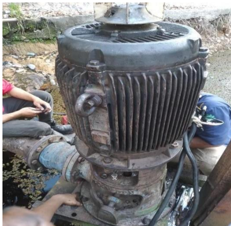
Gambar 2. 46 Memasang Elmot Waduk (Sumber: Dokumentasi di PTPN V SEI BUATAN )
