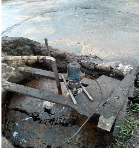
Gambar 2. 32 Elmot Pengutipan (Sumber: Dokumentasi di PTPN V SEI BUATAN ) Gambar 31 - Elmot Pengutipan
