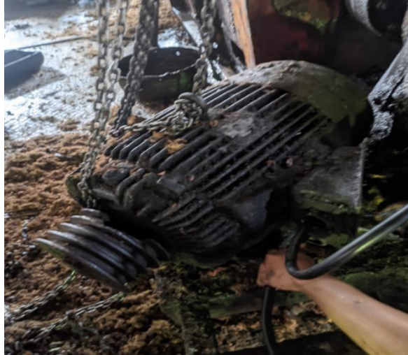
Gambar 2. 66 Memasang Elmot Presan (Sumber: Dokumentasi di PTPN V SEI BUATAN )
