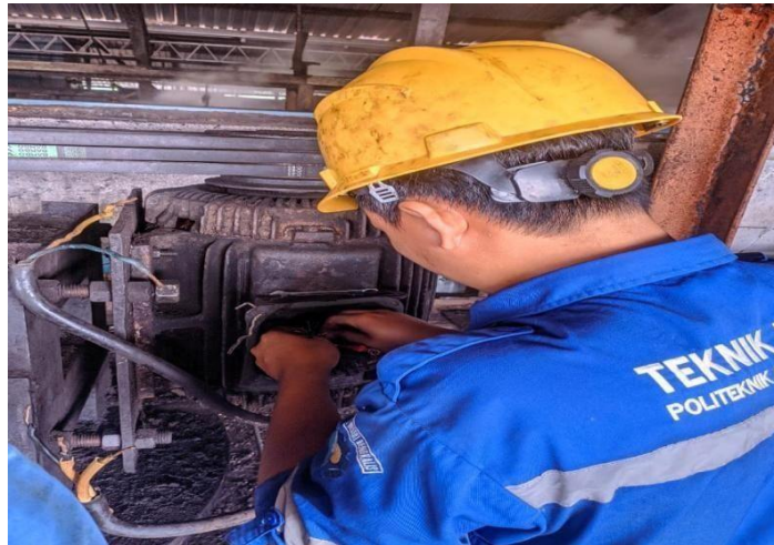
Gambar 2. 43 Memperbaiki Elmot Pompa Minyak
