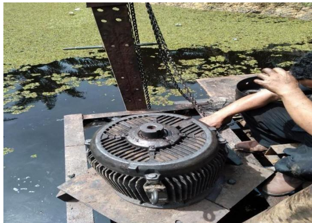
Gambar 2. 20 Memperbaiki Elmot Waduk
