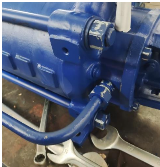
Gambar 4. 30 Pemasangan Flushing Pipe
