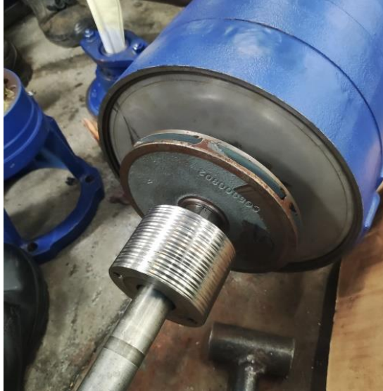
Gambar 4.23 Pemasangan Balance Drum
