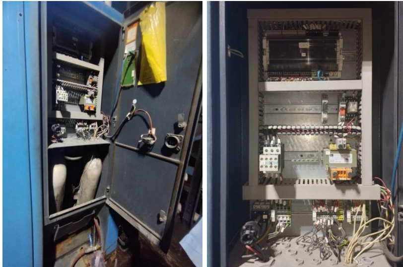
Gambar 4. 26 Tampilan dalam panel kontrol air dryer (Sumber: Dokumentasi di PT. Indah Kiat Pulp & Paper)
