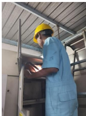
Gambar 2. 15 Melakukan pembersihan dan perawatan pada panel MCC.
