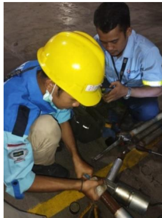
Gambar 2. 32 Melakukan test motor valve load dan unload compressor seah di PG 2.
