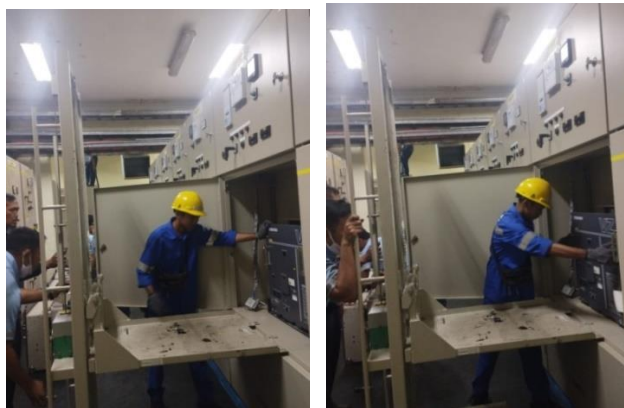
Gambar 2. 17 Melakukan pembersihan dan perawatan pada panel MCC dan switcgear .
