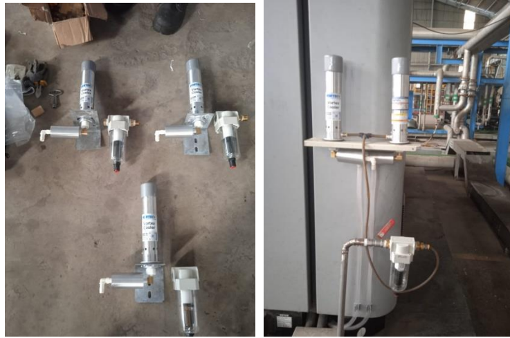
Gambar 3. 9 Cooler untuk pendingin panel compressor
