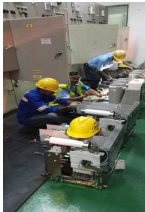
Gambar 2. 10 Membersihkan dan perawatan VCB ( Vacum Circuit Breaker ) ( Shutdown ).
