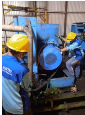
Gambar 2. 39 Mengganti dan memasang kabel power motor compressor dengan kabel yang baru
