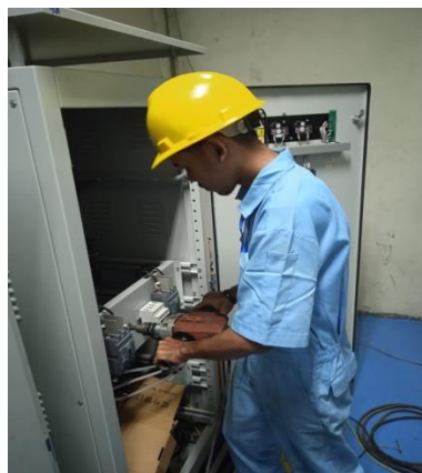
Gambar 2. 5 Membantu mengebor dan membuat kedudukan breaker di dalam panel DC 110 VDC.
