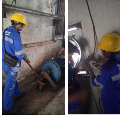
Gambar 2. 40 Membawa motor compressor ke workshop motor dan memasang fan pada scrap ac (Sumber: Dokumentasi di PT. Indah Kiat Pulp & Paper)
