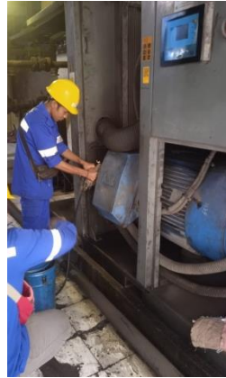
Gambar 2. 30 Memberi greas pada motor compressor di PB 2.
