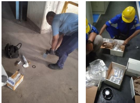
Gambar 2. 35 Membuat dudukan cooler sebagai pendingin panel compressor
