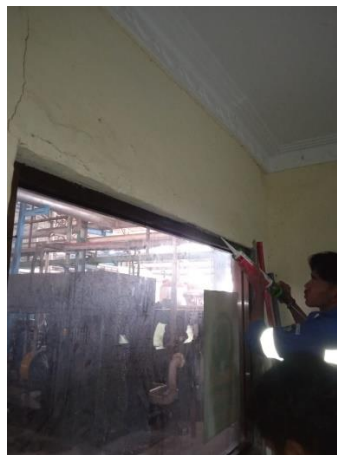
Gambar 2. 49 Memberi silicone pada jendela yang baru di pasang
