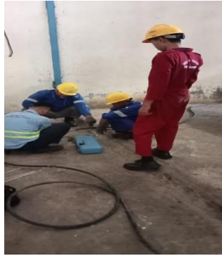
Gambar 2. 2 Membantu pemasangan kabel power panel DC 3 phase .
