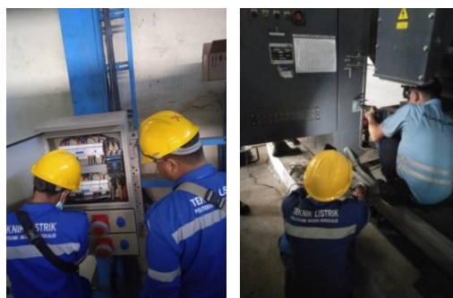
Gambar 2. 36 Memindahkan kabel power lampu dan memasang cooler pada panel compressor .
