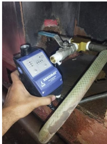
Gambar 2. 46 Memasang autodrain pada compressor di Power Generator 2
