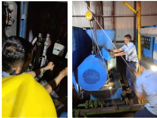
Gambar 2. 37 Membuka dan membongkar motor compressor siemens di PB 2
