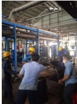
Gambar 2. 18 Menarik kabel 4cx95mm untuk motor pompa cooling water compressor .
