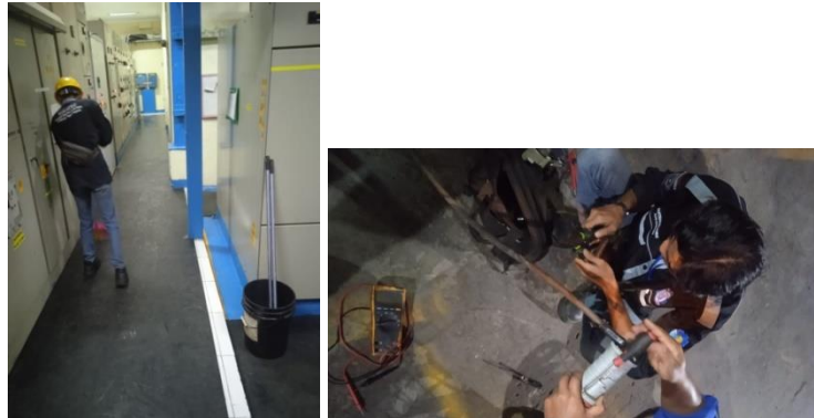
Gambar 2. 16 Melakukan cleaning di MCC room water 1 dan memasang socket power mesin gerinda.
