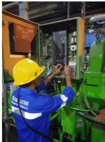
Gambar 2. 13 Mengecek arus pada sensor vibrasi yang telah dipasang.
