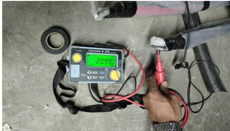
Gambar 2. 6 Nilai yang dihasilkan dari megger kabel 3,3 KV.
