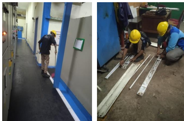
Gambar 2. 29 Membantu memasang instalasi lampu TL dan kipas angin di Mechanic room WT 1.
