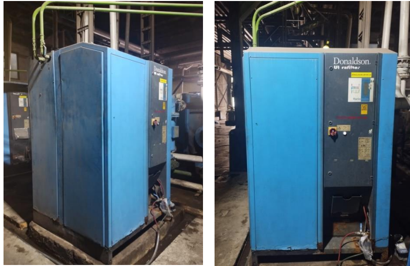
Gambar 4. 24 Tampilan samping dan depan air dryer merk Donaldson
