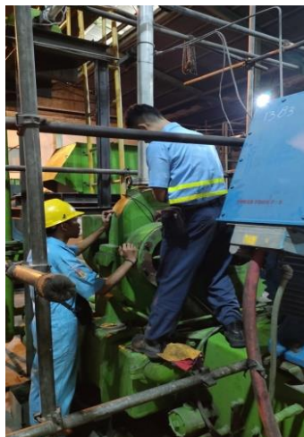
Gambar 2. 12 Membantu memasang sensor getar pada compressor .
