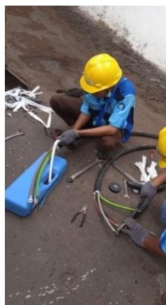
Gambar 2. 38 Mengupas kabel untuk kabel power motor compressor
