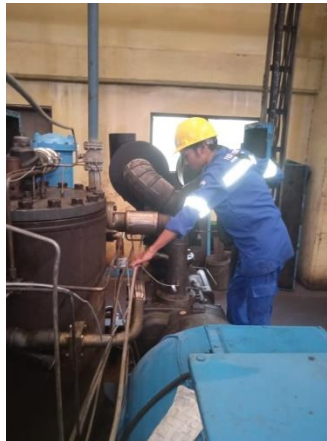
Gambar 2. 44 Memasang tubing stainless pada compressor 24C
