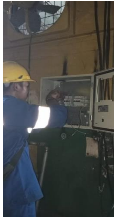
Gambar 2. 26 Memabantu memasang instalasi lampu TL di Mechanic room water 1 .
