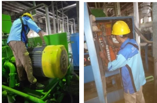
Gambar 2. 19 Melakukan cleaning body motor compressor dan local panel compressor .
