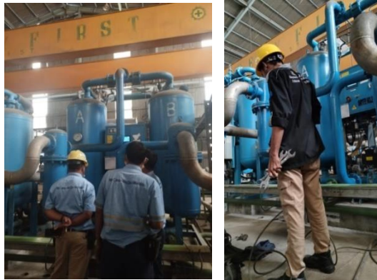
Gambar 2. 28 Membantu membuka valve dryer yang bermasalah dan melakukan perawatan.
