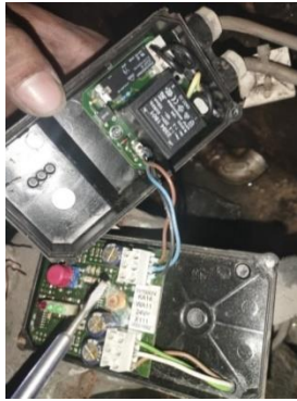
Gambar 2. 45 Memasang autodrain pada air dryer merk Donaldson
