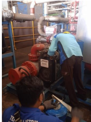
Gambar 2. 48 Memberi greas pada motor compressor
