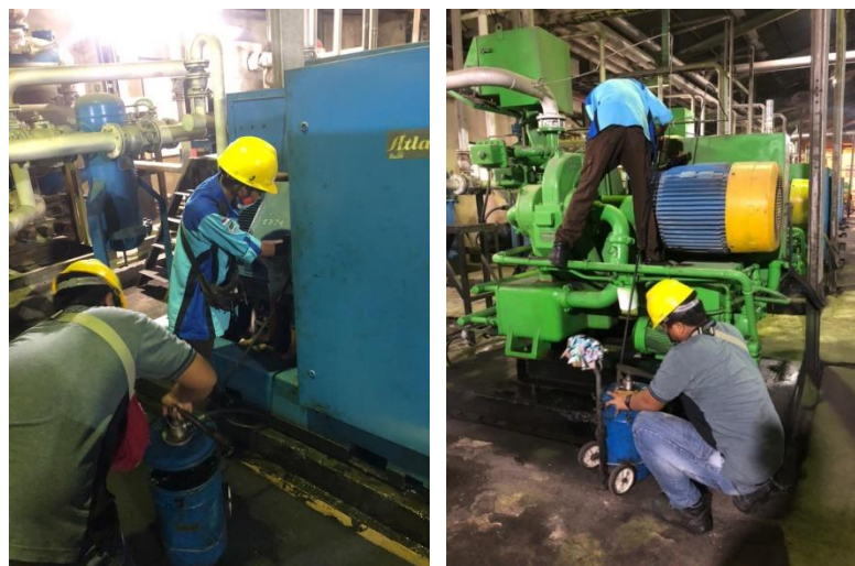
Gambar 2. 25 Memberikan greas pada motor compressor di PG 2.
