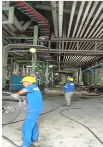
Gambar 2. 11 Membantu pemasangan kabel proteksi trafo untuk mencegah terjadinya gangguan. (Setelah shutdown ).
