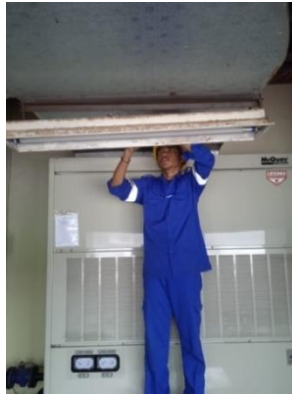
Gambar 2. 14 Membantu memasang lampu TL, stop kontak,dan saklar nya.
