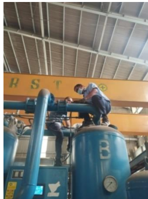
Gambar 2. 27 Membantu mengecek valve yang bermasalah dan melakukan perawatan pada valve .
