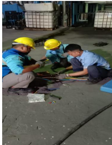
Gambar 2. 4 Menyambung dan menarik kabel 4 cm x 25mm ± 60 meter untuk panel 110 VDC.
