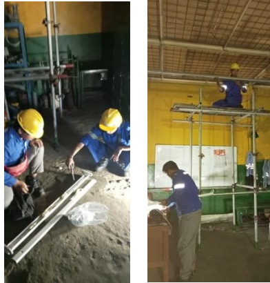
Gambar 2. 22 Membantu memasang instalasi lampu TL di Mechanic Water 1 .
