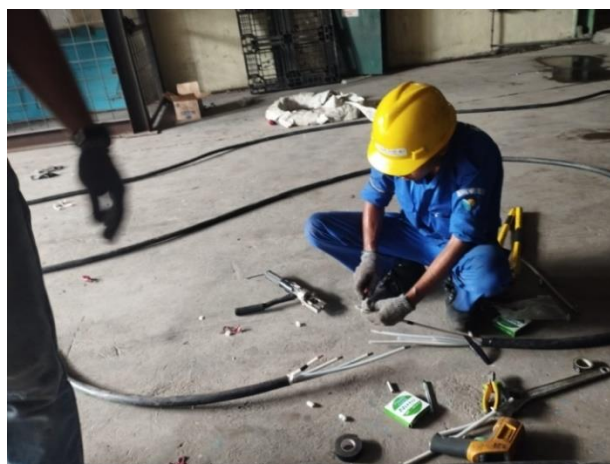
Gambar 2. 9 Terminating dan press skun kabel 4 cm x 25mm.
