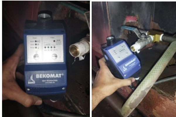
Gambar 3. 8 Autodrain pada dryer
