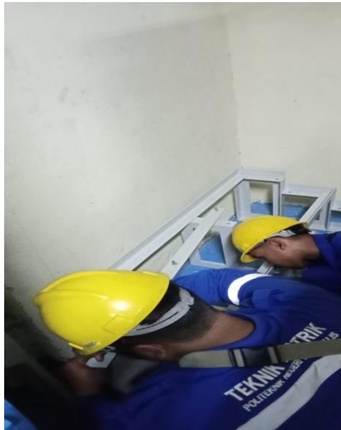
Gambar 2. 1 Pemasangan dudukan dan baterai 12VA untuk panel DC 3 phase .
