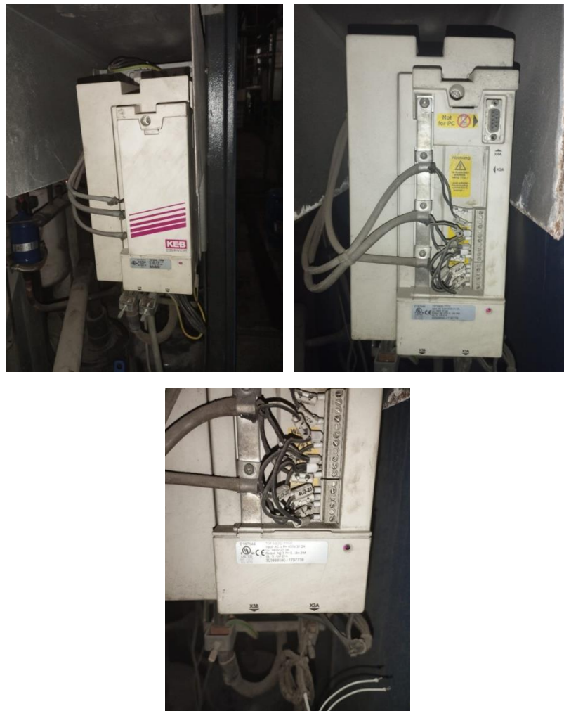
Gambar 4. 28 VSD dan Nameplate pada air dryer Donaldson di PG 2
