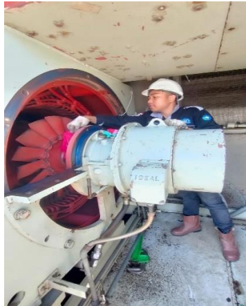
Gambar 2.5 Pemeliharaan generator turbin (Sumber : Dokumentasi pribadi 2022)
