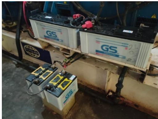
Gambar 4.6 Perawatan Baterai Starting (Sumber: dokumen pribadi)
