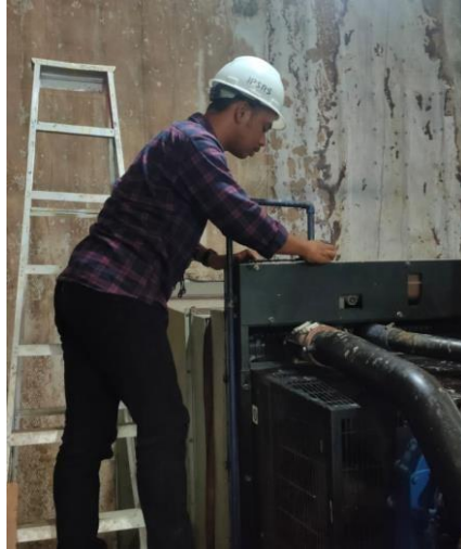
Gambar 4.4 Pengecekan Cairan Pendingin (Sumber: dokumen pribadi)
