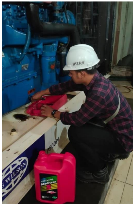
Gambar 4.1 Contoh Penggantian Oli (Sumber: dokumen pribadi)
