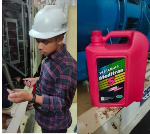
Gambar 4.3 Pengecekan Pelumas (Sumber: dokumen pribadi)
