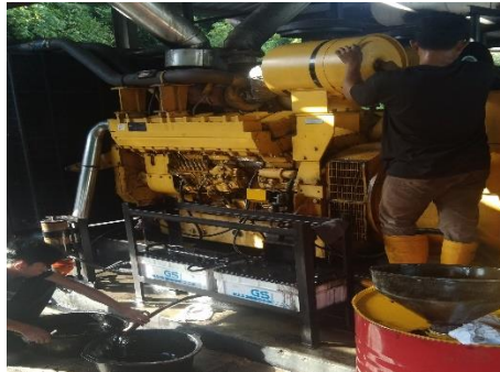
Gambar 2.19 Mengganti oli mesin dan filter (Sumber : PT.Megapower Makmur Tbk,2023)
