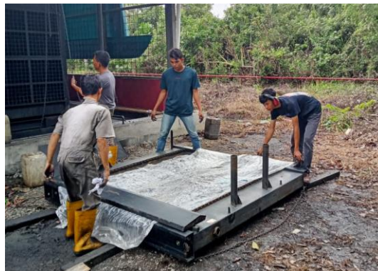
Gambar 2.25 Memindahkan radiator (Sumber : PT.Megapower Makmur Tbk,2023)
