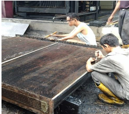
Gambar 2.24 Membersihkan radiator (Sumber : PT.Megapower Makmur Tbk,2023)
