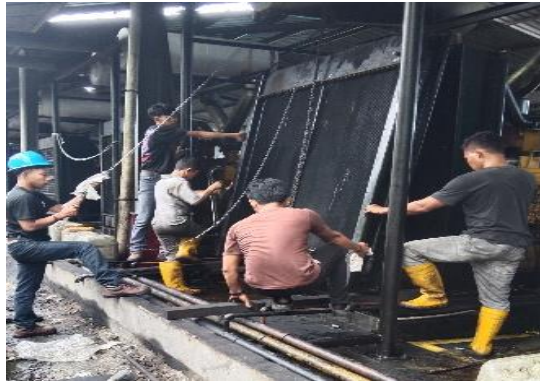
Gambar 2.8 Memindahkan radiator (Sumber : PT.Megapower Makmur Tbk,2023)
