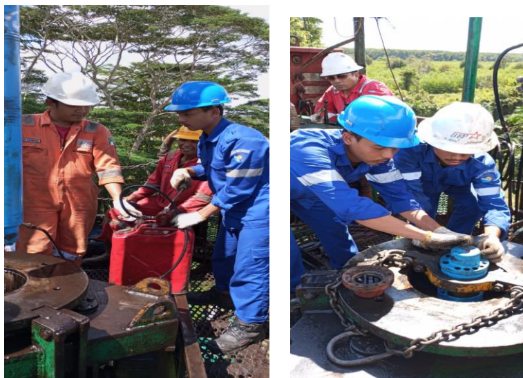
Gambar 2.5 Pemasangan pompa ESP di lokasi AC 28
