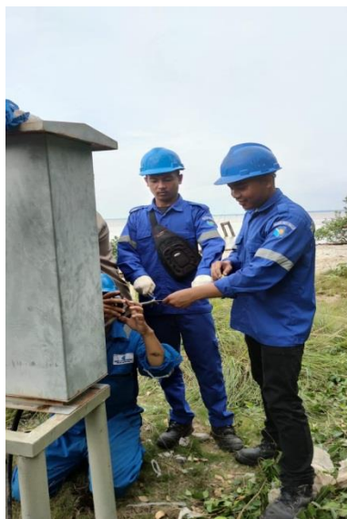
Gambar2.2 Penggantian dudukan panel lighting
