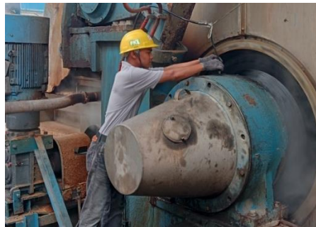
Gambar 4.24. Tambah Grease Pada Bearing MCO2 Wash Press Sumber: Dokumentasi Penulis
