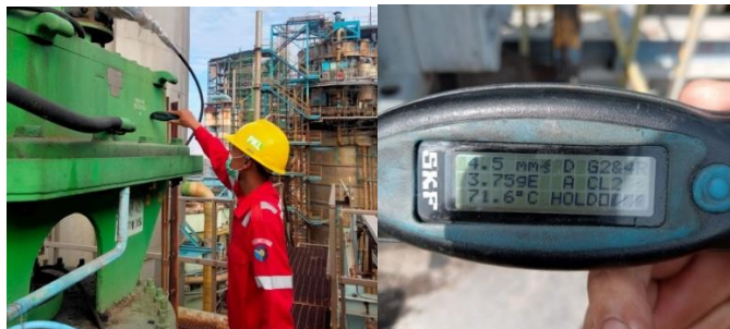
Gambar 4.19. Inspeksi Getaran/Vibrasi Gearbox Sumber: Dokumentasi Penulis
