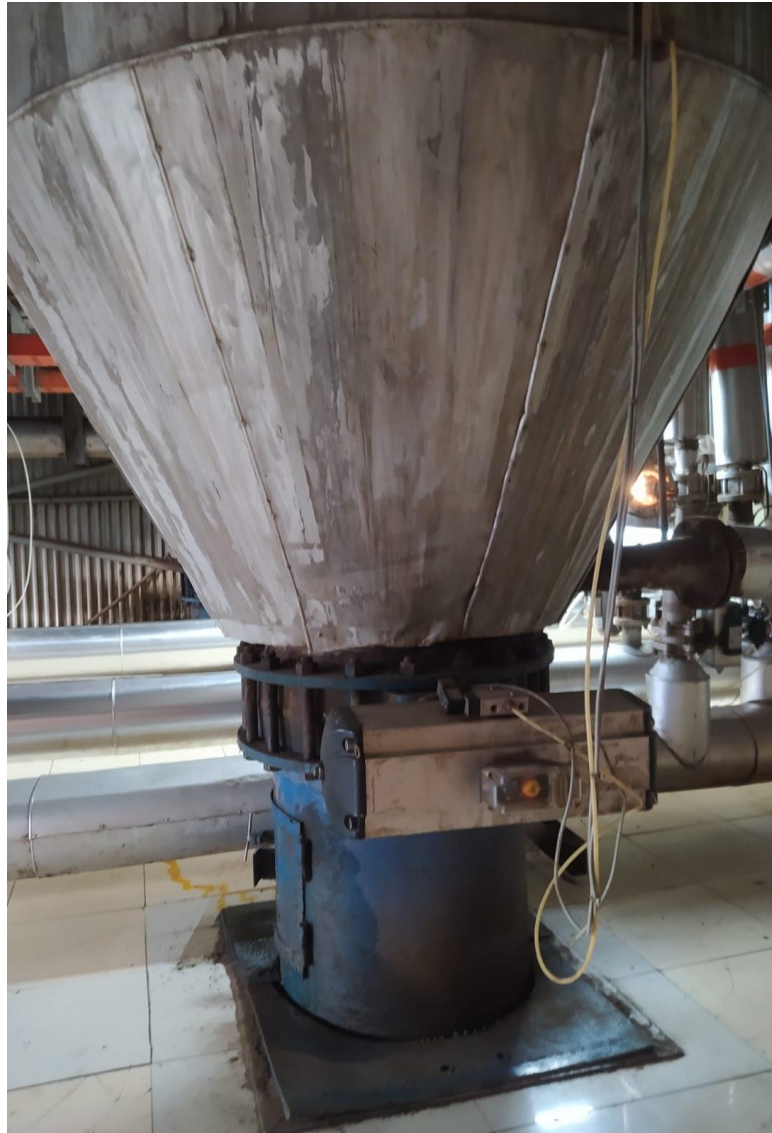
Gambar 4. 2 Niagara Lantai 2 (sumber: dokumentasi pribadi)
