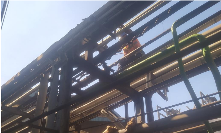
Gambar 3. 5 Welding Pipa Steam (sumber: dokumentasi pribadi)
