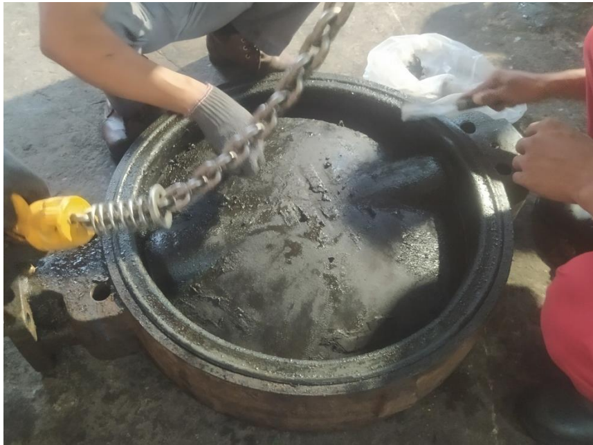
Gambar 3. 7 Repair Valve (sumber: dokumentasi pribadi)
