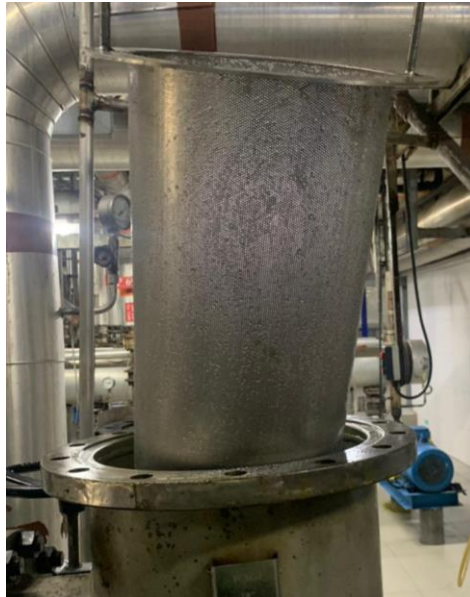
Gambar 3. 3 Strainer 1mm (sumber: dokumentasi pribadi)
