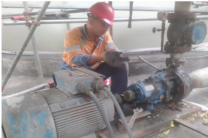
Gambar 3. 6 Repair Pompa Centrifugal (sumber: dokumentasi pribadi)
