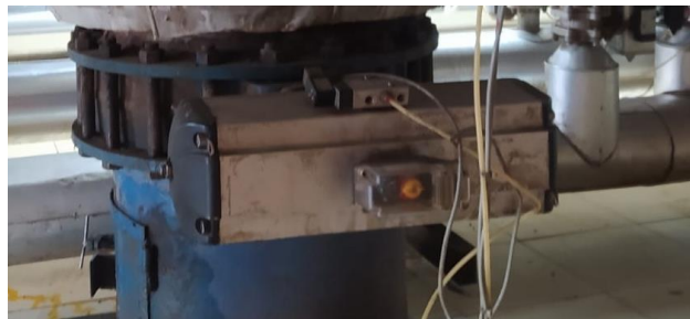
Gambar 4. 17 Actuator (sumber: dokumentasi pribadi)
