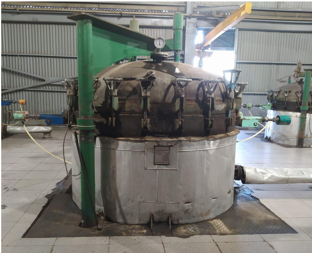
Gambar 4. 1 Niagara Lantai 3 (sumber: dokumentasi pribadi)
