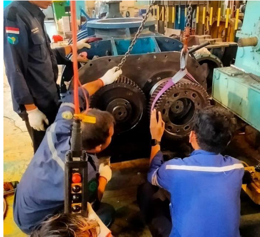
Gambar 4. 9 proses install gear Sumber. Dokumentasi pribadi
