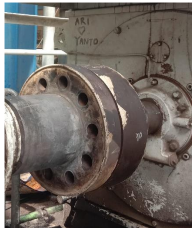
Gambar 4. 44 Pemasangan baut coupling
