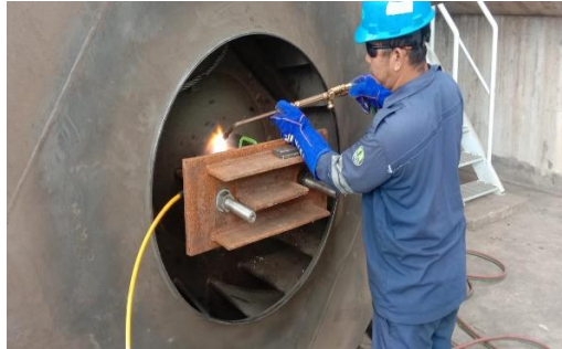
Gambar 4. 22 Pelepasan lock nut impeler
