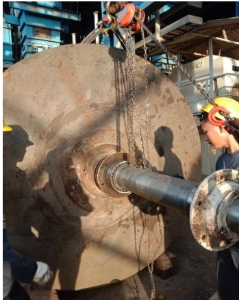
Gambar 4. 37 Proses pemasangan shaft dan impeller
