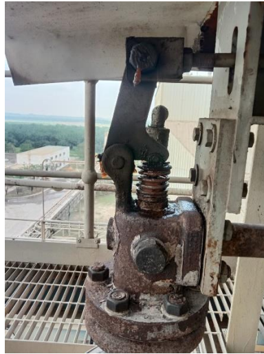
Gambar 3. 6 Perbaikan root blower
