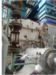
Gambar 4. 20 Pelepasan close vlave dan outlet cooler
