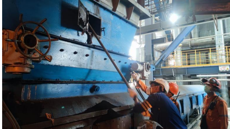
Gambar 3. 7 Perbaikan coal feeder
