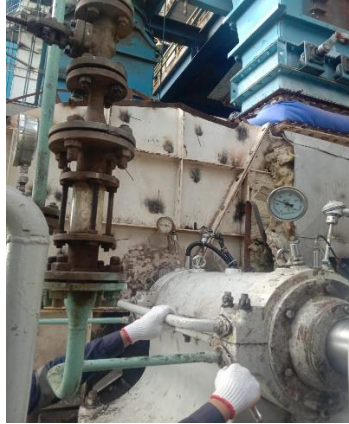
Gambar 4. 41 pemasangan cooler SA FAN
