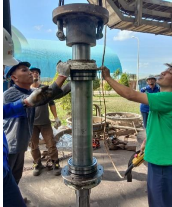
Gambar 4. 25 Pemindahan shaft dengan dengan wabing nilon
