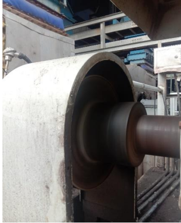
Gambar 4. 45 Pemasangan pelindung coupling
