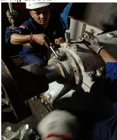
Gambar 4. 39 Casing penutup bearing SA FAN
