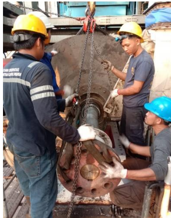
Gambar 2. 5 Corrective Maintenance pada Secondary Air Fan
