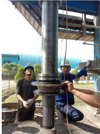
Gambar 4. 34 Proses pemasangan coupling
